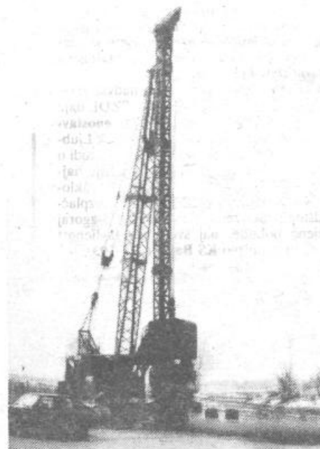
UTRJEVANJE TERENA – Na obeh straneh Ižanske ceste delavci vgrajujejo v traso do 15 metrov globoke gručnate »kole«.
