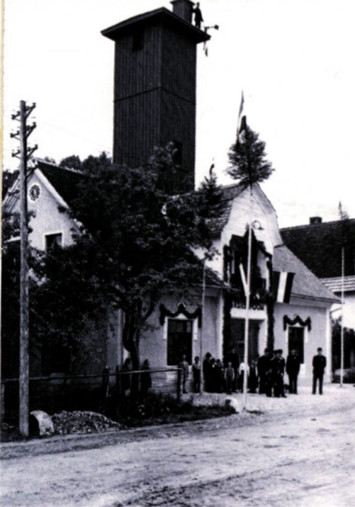
Nov gasilski dom leta 1932 Fotografija desno: slovesnost ob otvoritvi
