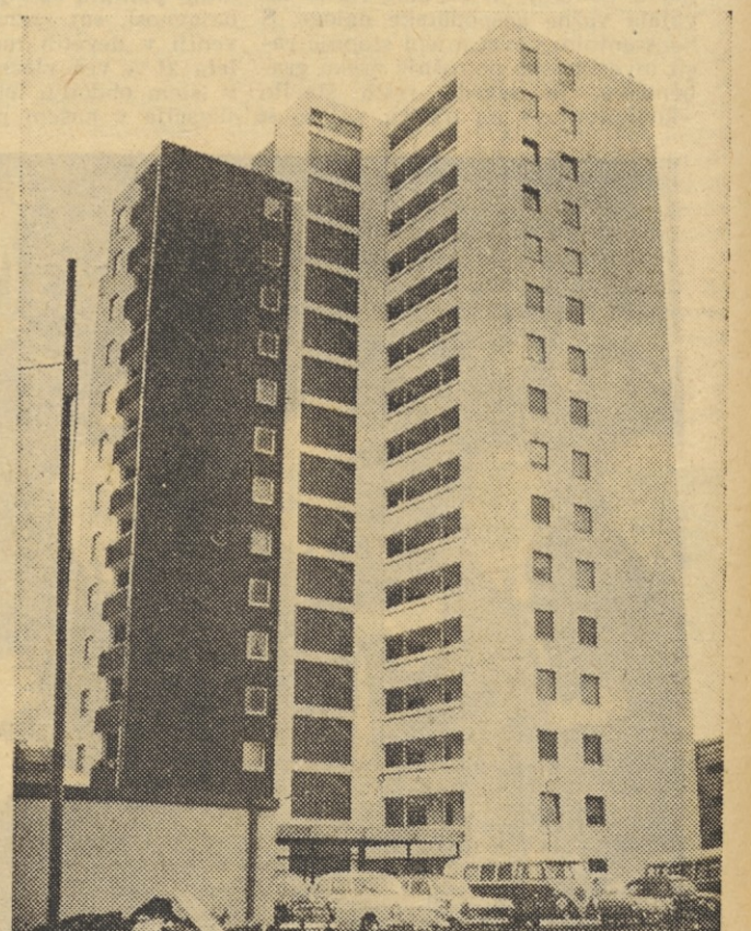
Stanovanjska stolpnica v Nordweststadtu pri Frankfurtu. Delali smo vse temelje in kleti za montažne stolpnice.
