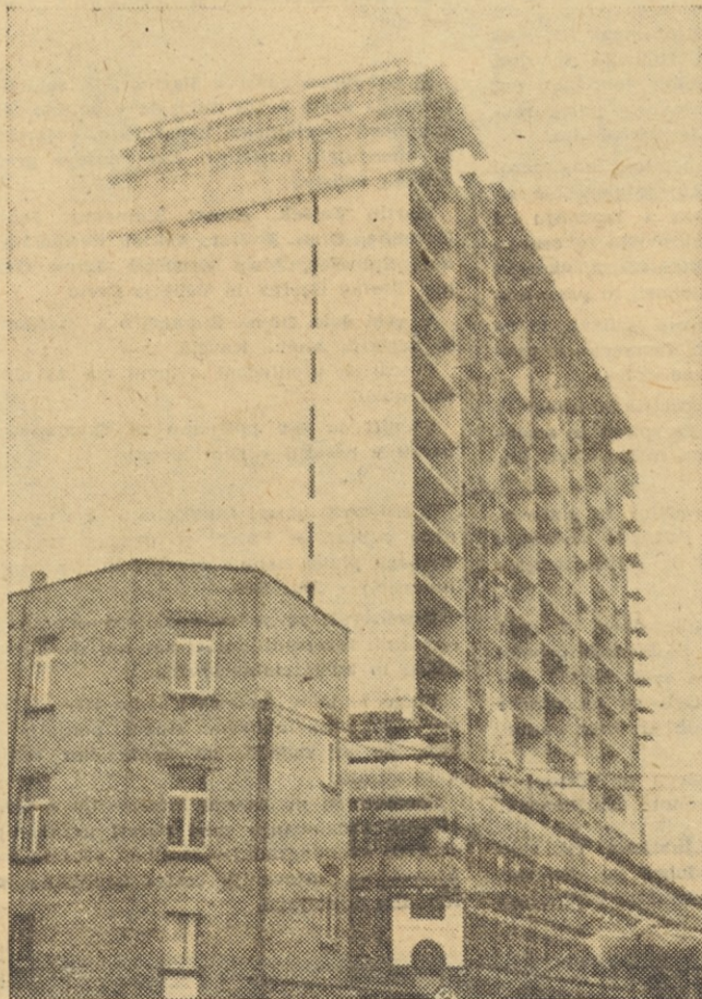
Henninger-Hochhaus, kjer smo prevzeli vsa tesarstva dela.
