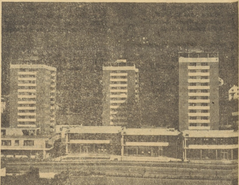
Z graditvijo stolpnice S-3 je zaključena prva faza stanovanjske gradnje.
