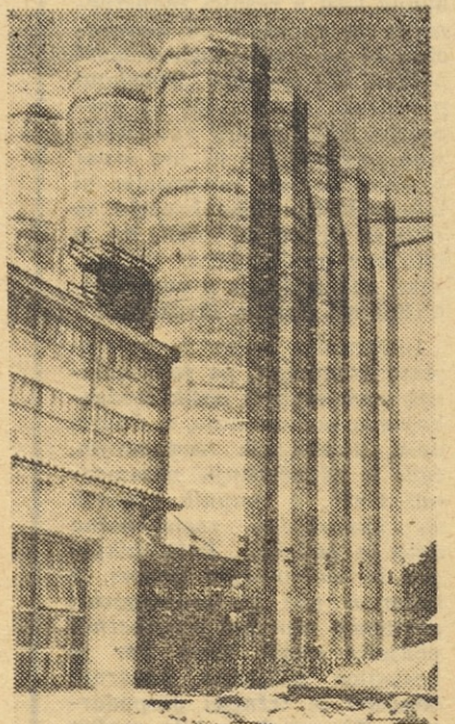
Med pomembne objekte, ki smo jih letos gradili v Celju, sodi žitni silos za 780 vagonov, mlin in podvoz v Celju ter gradnja velike žičnice na Mozirsko planino. Na sliki žitni silos
