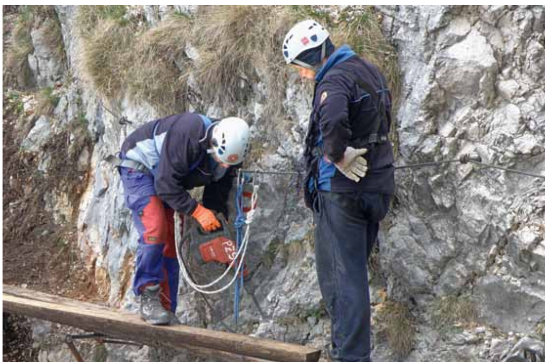
Vrtanje v skalo z veliko vrtalko FOTO: DUŠAN ŠKODIČ
