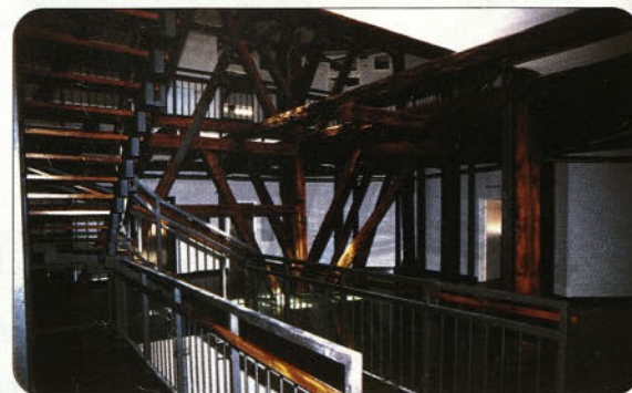
Ohranjena lesena konstrukcija na podstrešju, Foto: Langerholz
