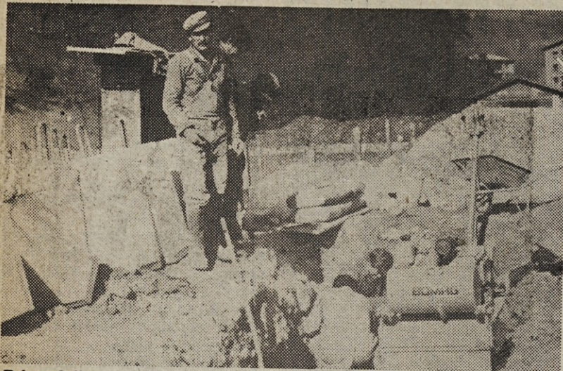
Pri gradnji samskega doma za železarno Ravne je bilo treba zaradi slabega terena poglobiti in utrditi temelje za žerjavno progno
