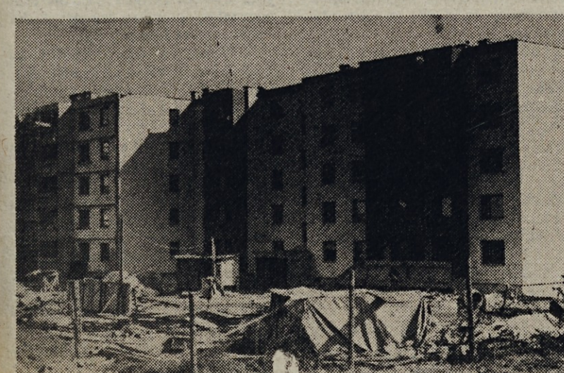
Delo na bloku 7 Javornik se zaključuje.
