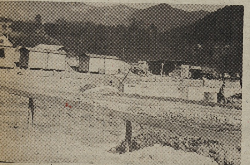
Za Avtoprevoz Dravograd so temelji nared
