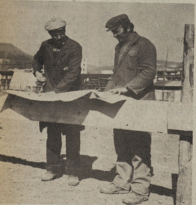
Delovodja Franc Turk in VK zidar Jože Toplak nastavljata temelje za novo stolpnico na Javorniku, v kateri bo 90 stanovanj
