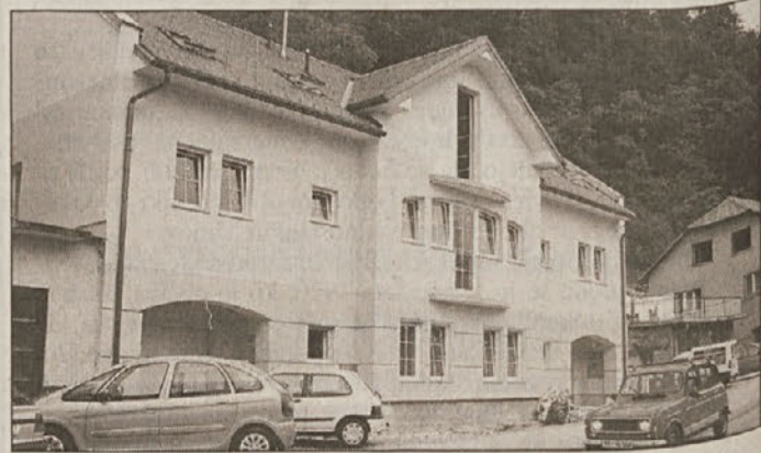
V poslovno stanovanjskem objektu so kadrovska stanovanja.
