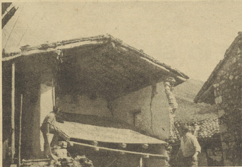
Breginj: hiša se je praktično podrla, vendar bi pode, ki so ostali celi, radi uporabili za gradnjo stanovanjske barake. Reševanje je nevarno in treba bo najti primernejši način, kako osvoboditi nepoškodovan pod iz ruševin.
