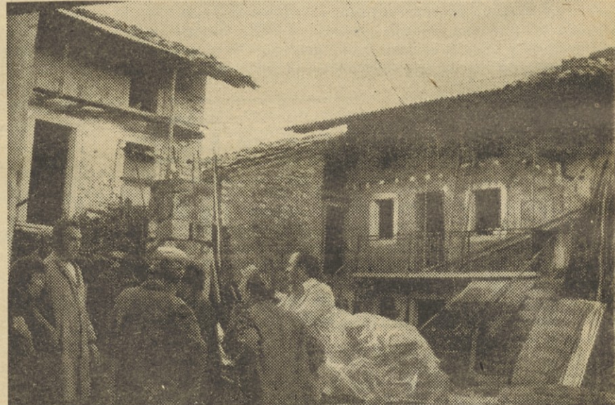
„Niti ena hiša v Robedišču po zadnjem potresu ni utrpela nikakršne škode,“ je zatrdil Jože Centič iz Robedišča. „Vse, kar so popravili brigadirji in gradbeni delavci, je vzdržalo potres. Žal pa je res nekaj, da sanirana hiša pomeni le trdno in močno ogrodje in streho in da kljub temu, da nekateri že imamo sanirano hišo, še vedno spimo pod šotorom. Res je prikolic na Tolminskem dovolj, toda po cesti v Robedišče jih ne morejo pripeljati. Zato si vsi čimprej želimo iz šotorov med trdne in tople zidove. Še veliko dela nas čaka...“
