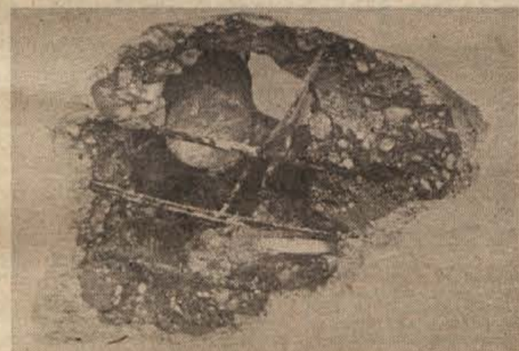
Takole so delavci 3. januarja razbili strop v stanovanju na novomeških Mestnih njivah
