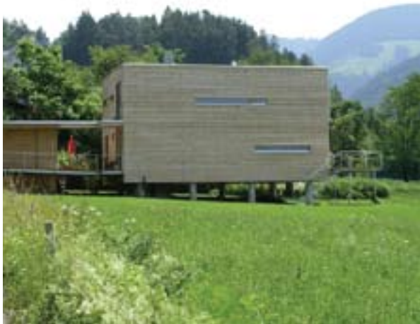
V sosednji Avstriji je vse več hiš zgrajenih v skladu z načeli energetske varčne gradnje.
