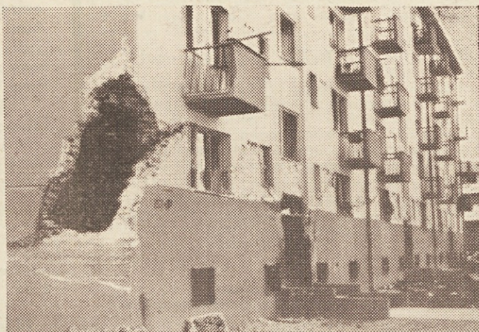
Pokončne slike zgoraj: Zitni silos, eden zidan iz opeke, drugi je iz armiranega betona. Oba sta bila polna. Prvi se je podrli, drugi je ostal nepoškodovan. Primer poškodb ometa pri skeletni stanovanjski zgradbi. Armirano betonske vezi še držijo. Ležeče slike ob strani in spodaj: Opečna zgradba z lesenim stropom brez železnih vezi. Treba jo bo podreti. Drugo nadstropje je pristalo v pritličju. Stavbi sta enaki. Potresni sunek je bil v eni smeri. Lupina pri železniški postaji. Podpore so se razmaknile in ločna konstrukcija je izgubila oporo. Opečna stanovanjska zgradba. S slike je razvidno, da so od potresnega sunka poškodovani predvsem opečni slopi v pritličju. Opečni vogali so pri potresu zelo izpostavljeni rušenju, ker so togi.
