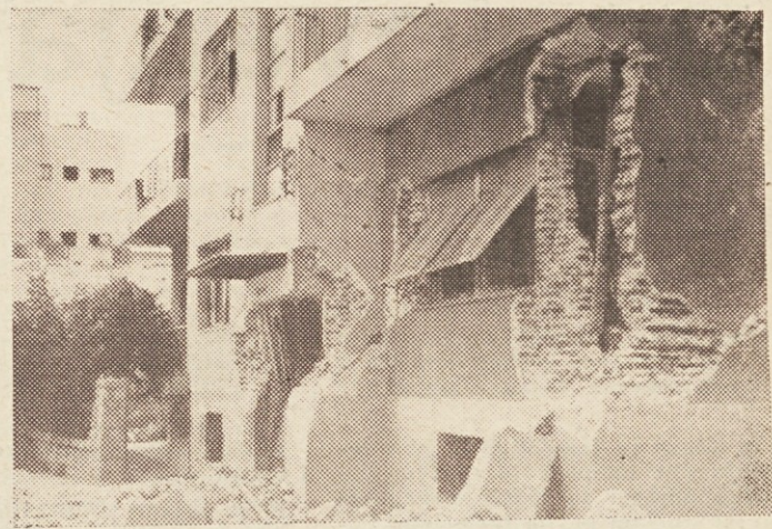
Pokončne slike zgoraj: Zitni silos, eden zidan iz opeke, drugi je iz armiranega betona. Oba sta bila polna. Prvi se je podrli, drugi je ostal nepoškodovan. Primer poškodb ometa pri skeletni stanovanjski zgradbi. Armirano betonske vezi še držijo. Ležeče slike ob strani in spodaj: Opečna zgradba z lesenim stropom brez železnih vezi. Treba jo bo podreti. Drugo nadstropje je pristalo v pritličju. Stavbi sta enaki. Potresni sunek je bil v eni smeri. Lupina pri železniški postaji. Podpore so se razmaknile in ločna konstrukcija je izgubila oporo. Opečna stanovanjska zgradba. S slike je razvidno, da so od potresnega sunka poškodovani predvsem opečni slopi v pritličju. Opečni vogali so pri potresu zelo izpostavljeni rušenju, ker so togi.
