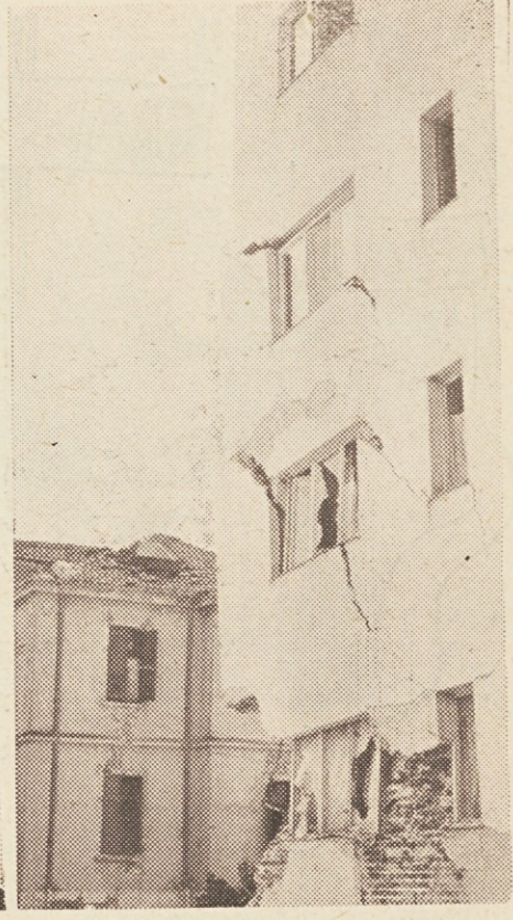
Pokončne slike zgoraj: Zitni silos, eden zidan iz opeke, drugi je iz armiranega betona. Oba sta bila polna. Prvi se je podrli, drugi je ostal nepoškodovan. Primer poškodb ometa pri skeletni stanovanjski zgradbi. Armirano betonske vezi še držijo. Ležeče slike ob strani in spodaj: Opečna zgradba z lesenim stropom brez železnih vezi. Treba jo bo podreti. Drugo nadstropje je pristalo v pritličju. Stavbi sta enaki. Potresni sunek je bil v eni smeri. Lupina pri železniški postaji. Podpore so se razmaknile in ločna konstrukcija je izgubila oporo. Opečna stanovanjska zgradba. S slike je razvidno, da so od potresnega sunka poškodovani predvsem opečni slopi v pritličju. Opečni vogali so pri potresu zelo izpostavljeni rušenju, ker so togi.
