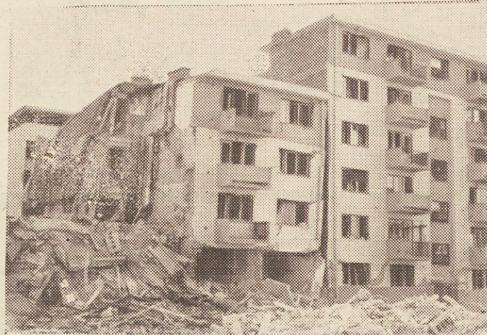
Pokončne slike zgoraj: Zitni silos, eden zidan iz opeke, drugi je iz armiranega betona. Oba sta bila polna. Prvi se je podrli, drugi je ostal nepoškodovan. Primer poškodb ometa pri skeletni stanovanjski zgradbi. Armirano betonske vezi še držijo. Ležeče slike ob strani in spodaj: Opečna zgradba z lesenim stropom brez železnih vezi. Treba jo bo podreti. Drugo nadstropje je pristalo v pritličju. Stavbi sta enaki. Potresni sunek je bil v eni smeri. Lupina pri železniški postaji. Podpore so se razmaknile in ločna konstrukcija je izgubila oporo. Opečna stanovanjska zgradba. S slike je razvidno, da so od potresnega sunka poškodovani predvsem opečni slopi v pritličju. Opečni vogali so pri potresu zelo izpostavljeni rušenju, ker so togi.
