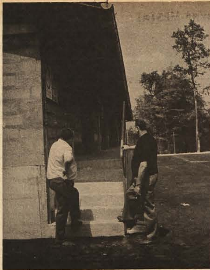
Skladišče plinskih jeklenk na Cikavi za zdaj še brez obiskovalcev, kmalu pa bo tu gneča. Letos pričakujejo že 6.000 odjemalcev gospodinjstvih in tehničnih plinov. (Foto: I. Zoran)
