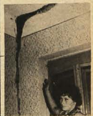
Pri Šeligojevih v Zibiki na Kozjanskem so za preureditev stanovanja porabili več milijonov, ob potresu pa se je hiša brez trdnega venca razklenila. Zraven nje stoji stara hišica, ki je niso posodabljali, pa je ostala brez večjih poškodb.
