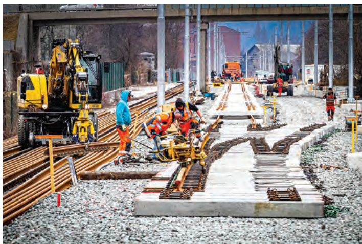
Pod betonskimi pragovi bo nameščen tolčenec eruptivnega izvora, ki je v primerjavi s klasičnim trši, bolj odporen.
