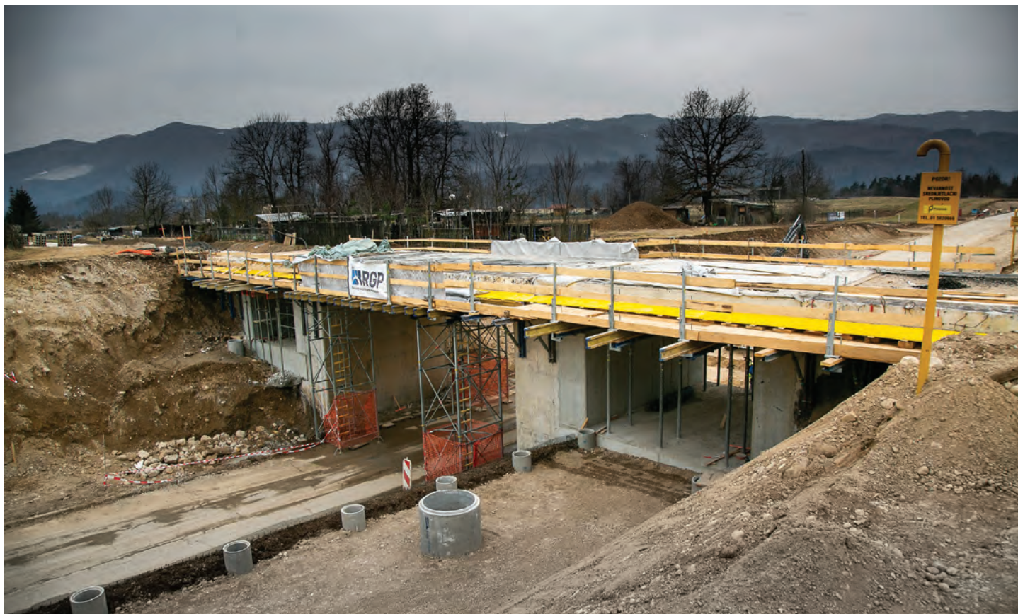
Dela na gorenjski progi se intenzivno nadaljujejo. Na fotografiji sanacija nadvoza pri Lescah.
