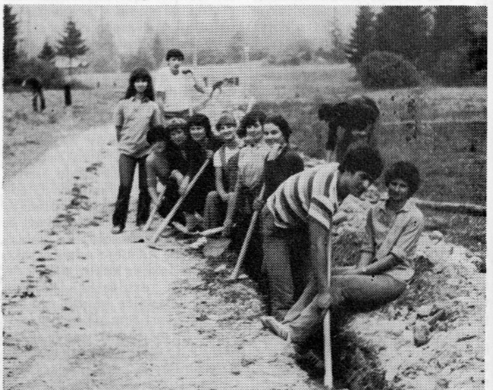
Pridne roke mladih so pripomogle k temu, da je bilo delo hitreje in ceneje opravljeno. Pri izkopu in zasutju kanala za telefonski kabel so se posebej izkazali mladi iz TOZD Tkalnica.
