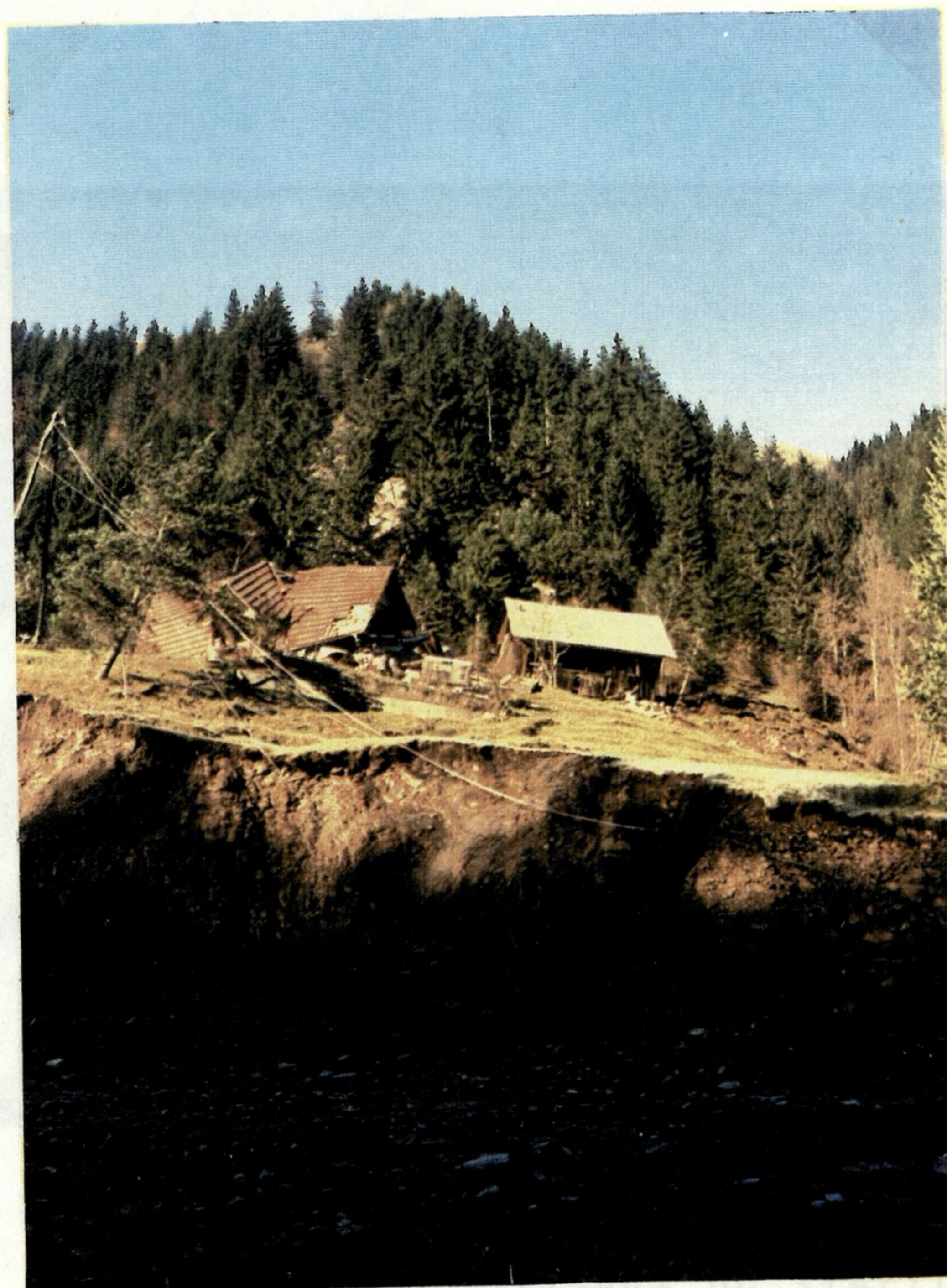
SLIKA št. 2 : Plaz v Podveži je zaježil strugo hudournika Lučnica ca 18 m visoko (foto: A.Horvat, 1990)
