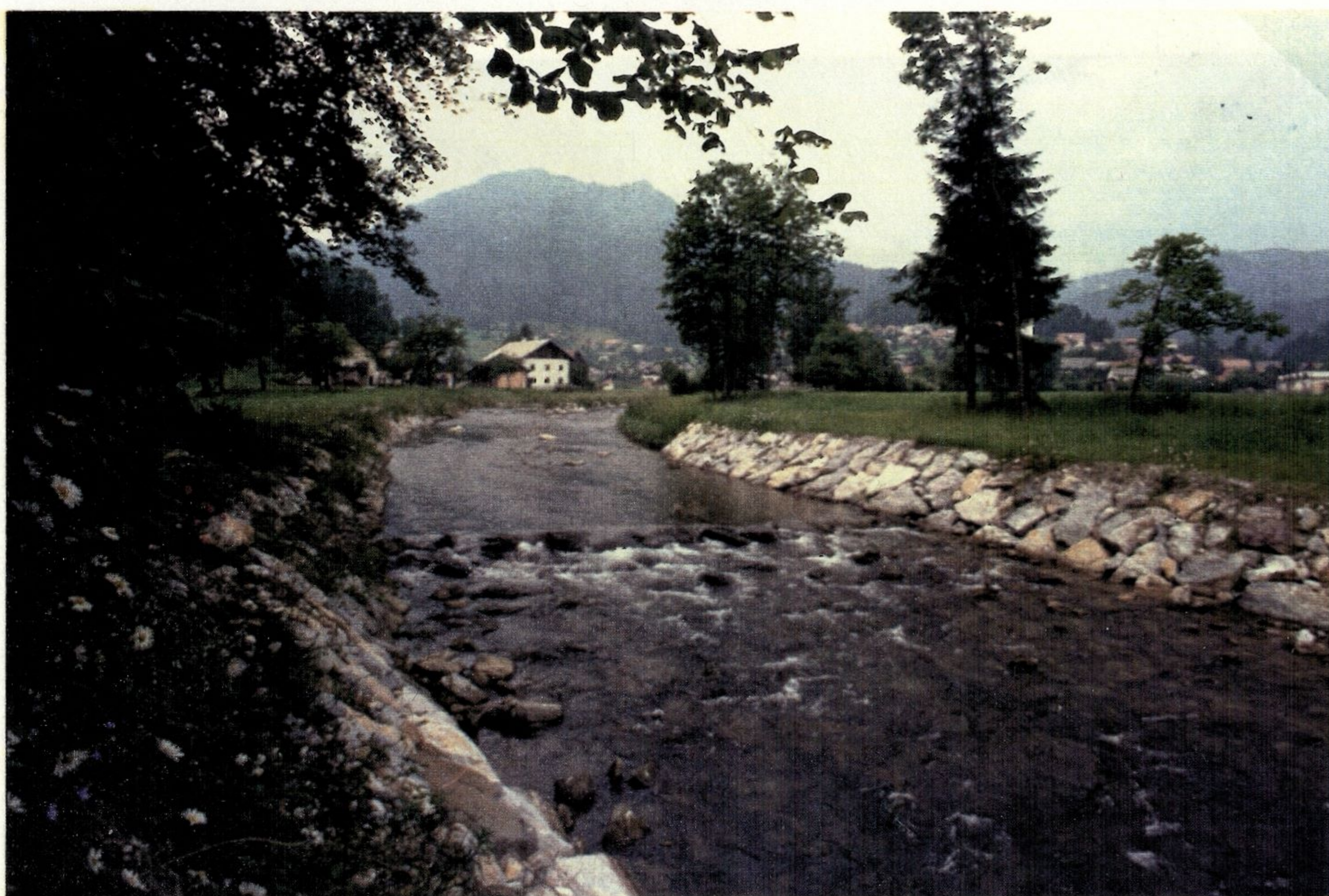
SLIKA št. 29 : Prag v obliki skalne zložbe - drča, pod izlivom Male vode v Gradaščico (foto: M.Zemljic, 1988)
