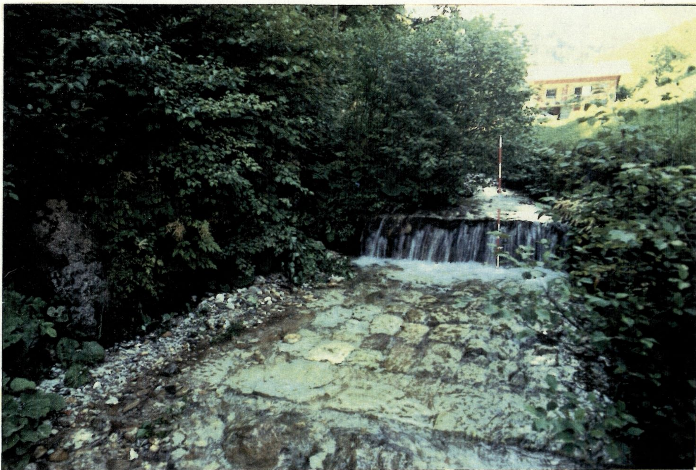
SLIKA št. 26 : BELICA - enakomerno prelivanje vode čez preliv praga (foto: M.Zemljič, 1988)
