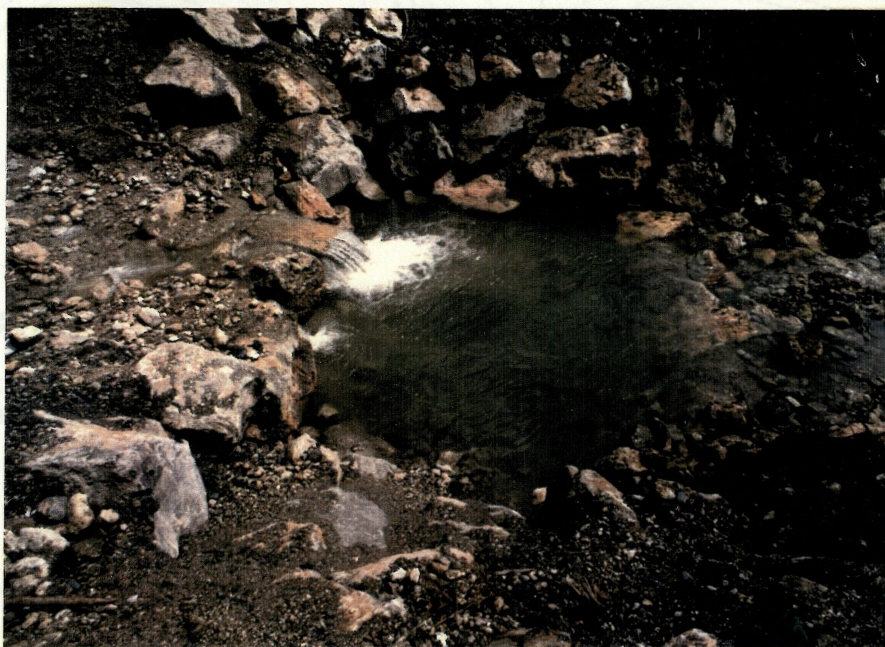
SLIKA št. 33 in 34 : BISTRIČICA-primeri pragov s stopnjo - kamnita zložba - s prelivom, oblikovanim za osredotočeno odtekanje vode, in s podslapnim tolmunom, izvedenim z upoštevanjem naravne granulacije naplavin po dnu (foto: A.Zajc, 1992)
