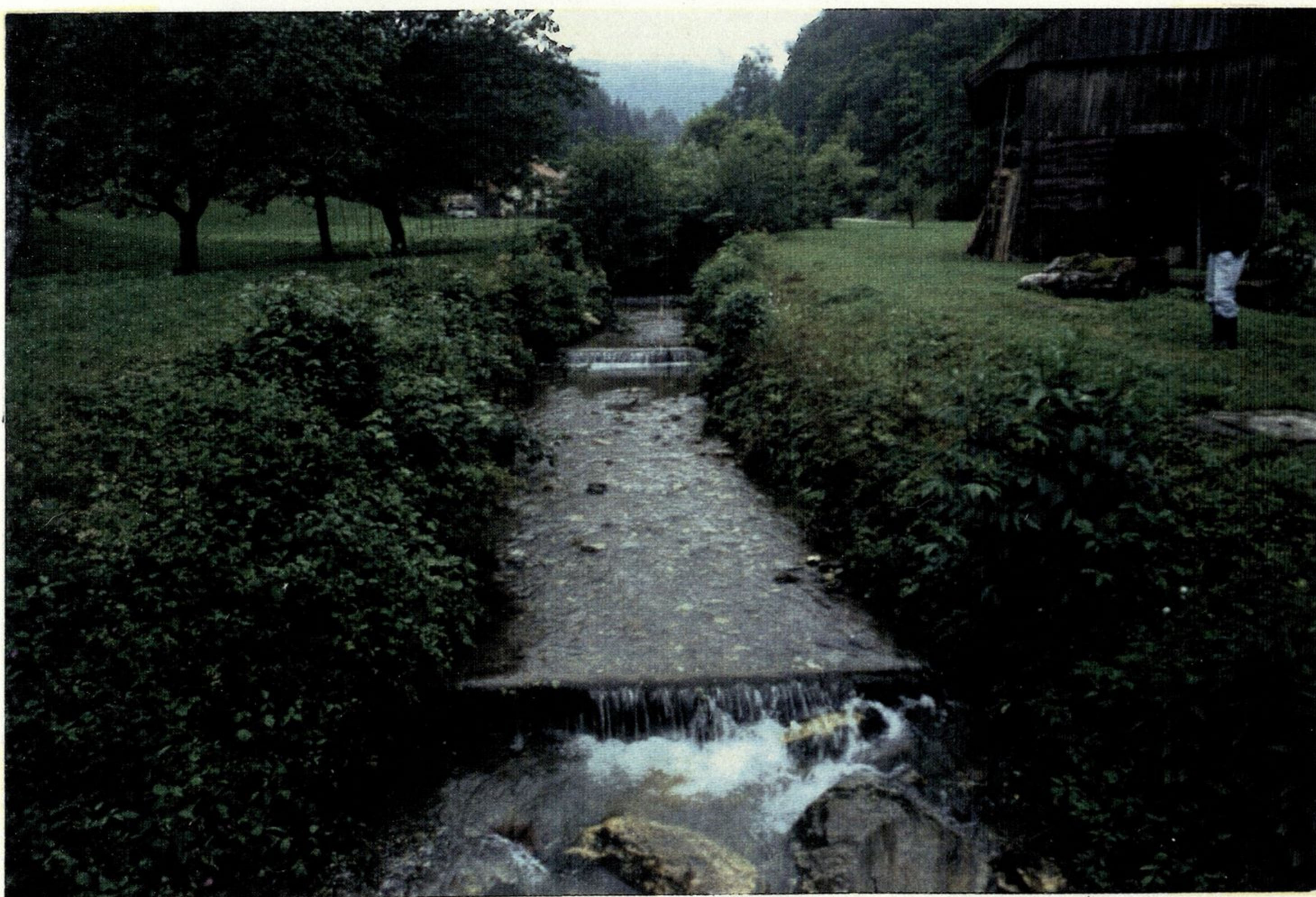
SLIKA št. 14 : ŽEROVNIKOV GRABEN - manj prikladna premočrtna ureditev (foto: M.Zemljic, 1988)
