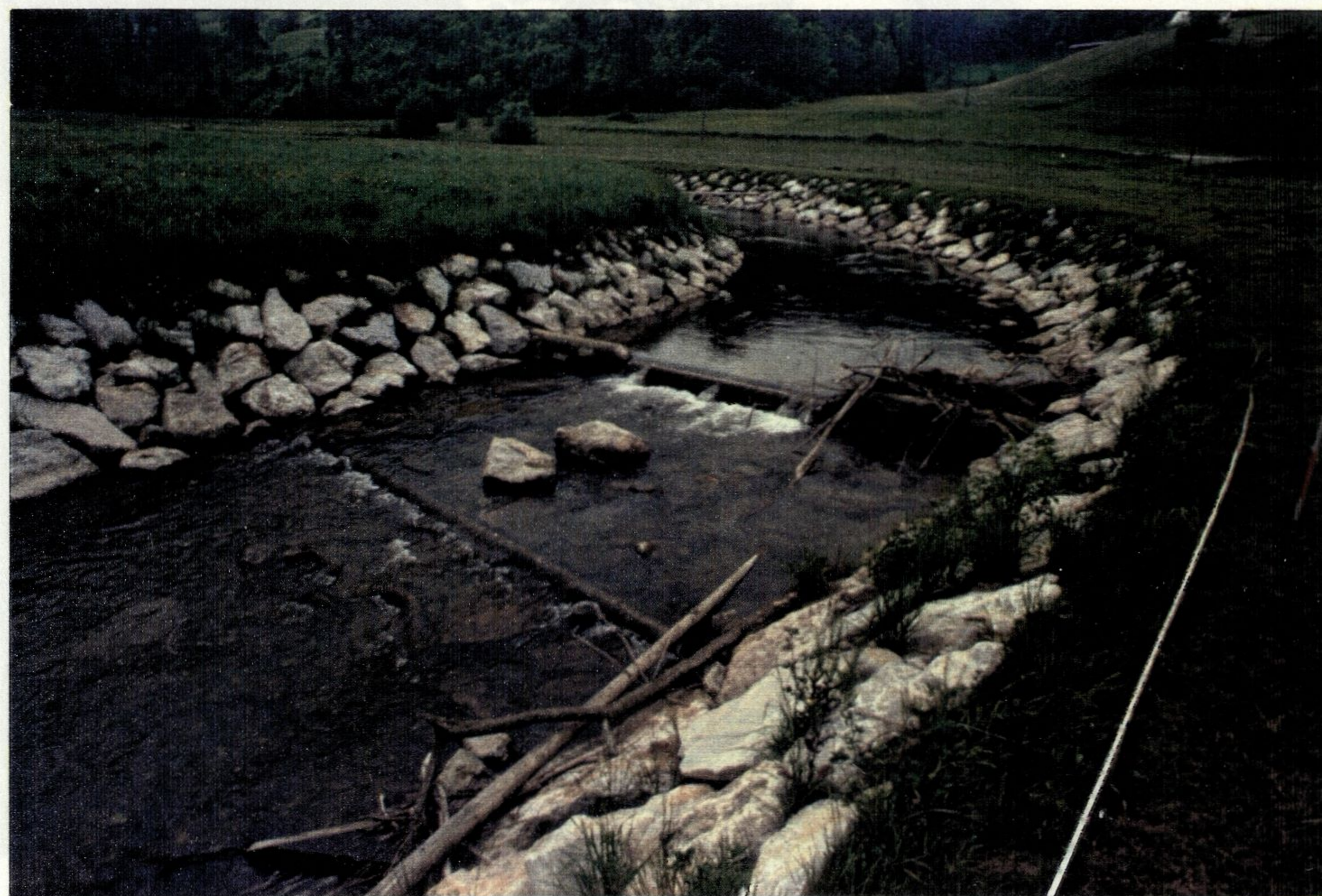
SLIKA št. 27 : MALA VODA pri Brišah - lesen prag s krilnim nadvišanjem (foto: M.Zemljic, 1988)
