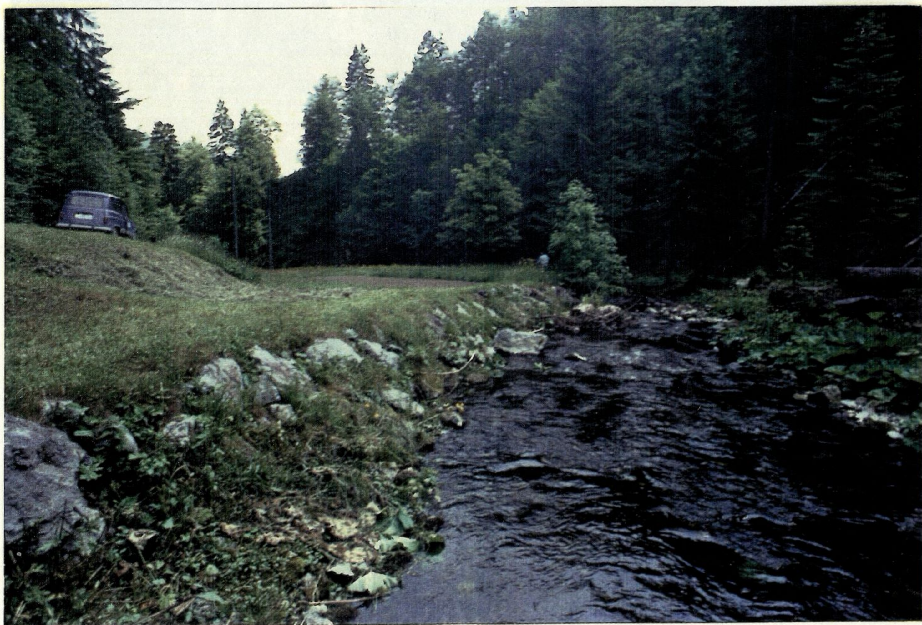
SLIKA št. 32 : MALA VODA nad Cepinom - deflektorji povzročajo globinsko in širinsko razgibanost struge (foto: M.Zemljic, 1988)
