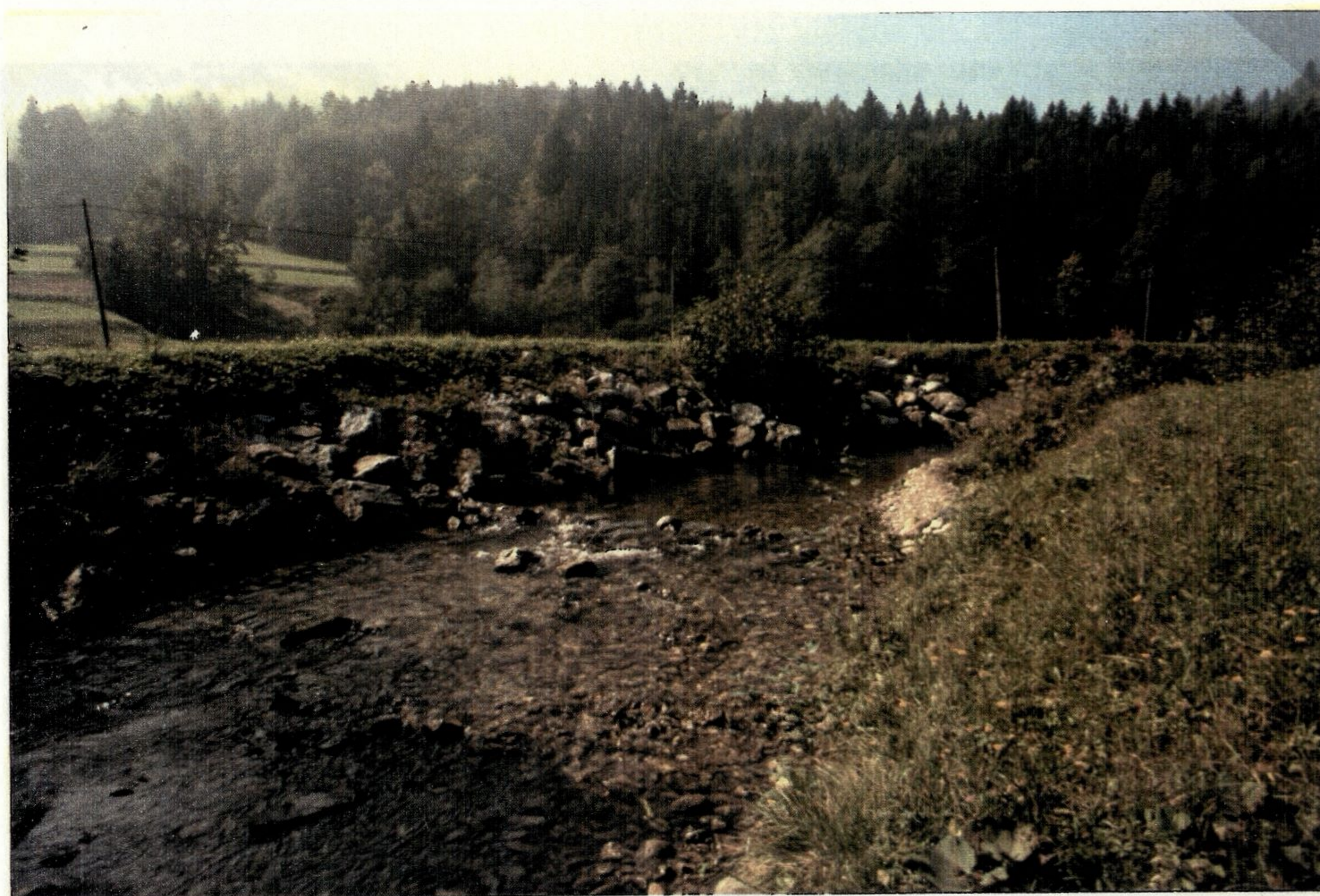
SLIKA št. 23 : VELIKA BOŽNA pod Zalogom - nesimetrično oboje- stransko zavarovanje (foto: M.Zemljic, 1988)
