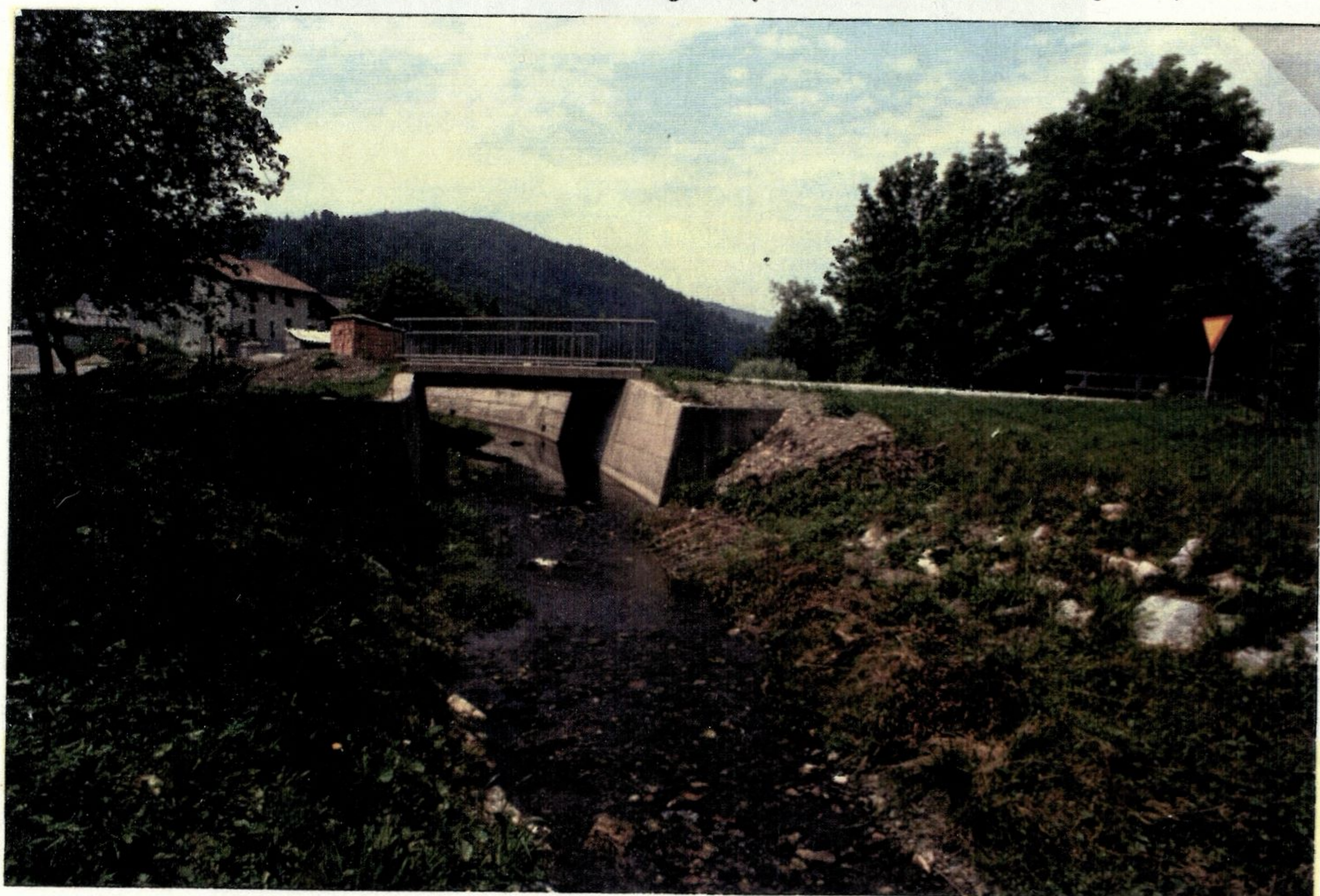
SLIKA št. 22 : PROŠCA - obojestransko - simetrično zavarovanje (foto: M.Zemljic, 1988)
