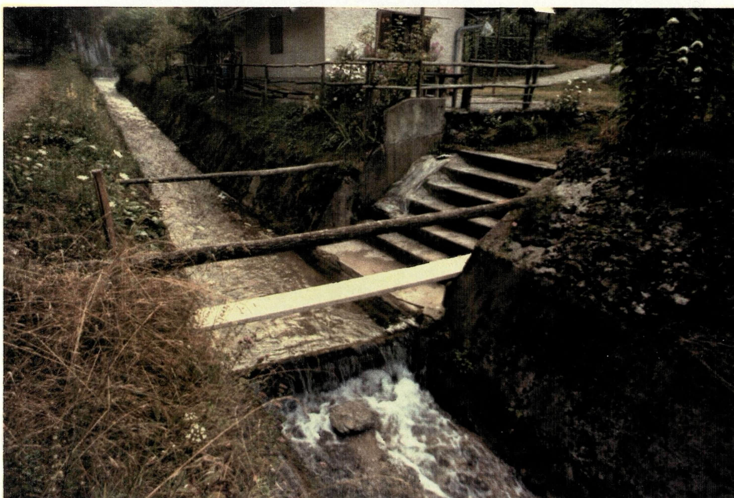
SLIKA št. 17 : MAČKOV POTOK - klasična, gladka izvedba kinete (foto: M.Zemljic, 1988)
