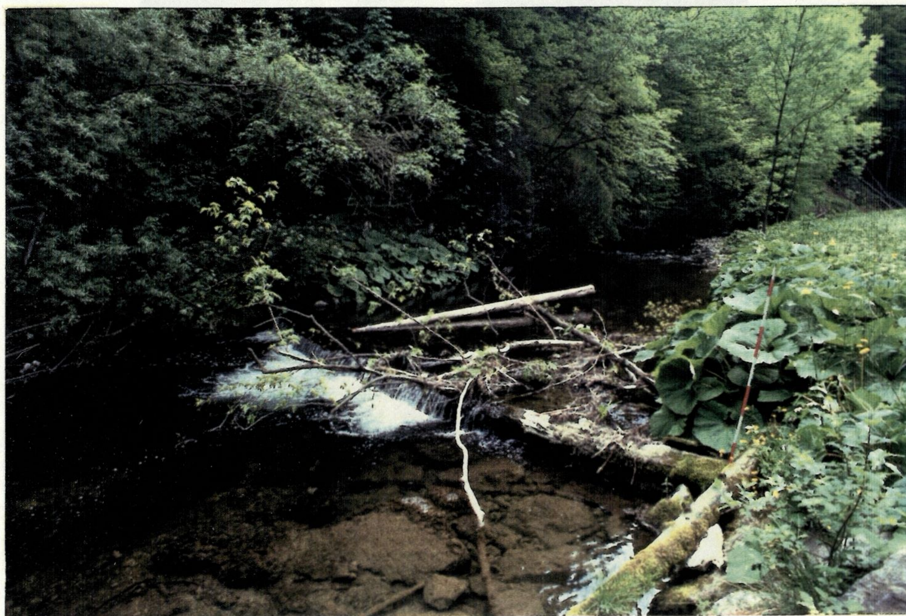
SLIKA št. 28 : MALA VODA nad Cepinom - lesen prag s podslapnim tolmunom (foto: M.Zemljic, 1988)
