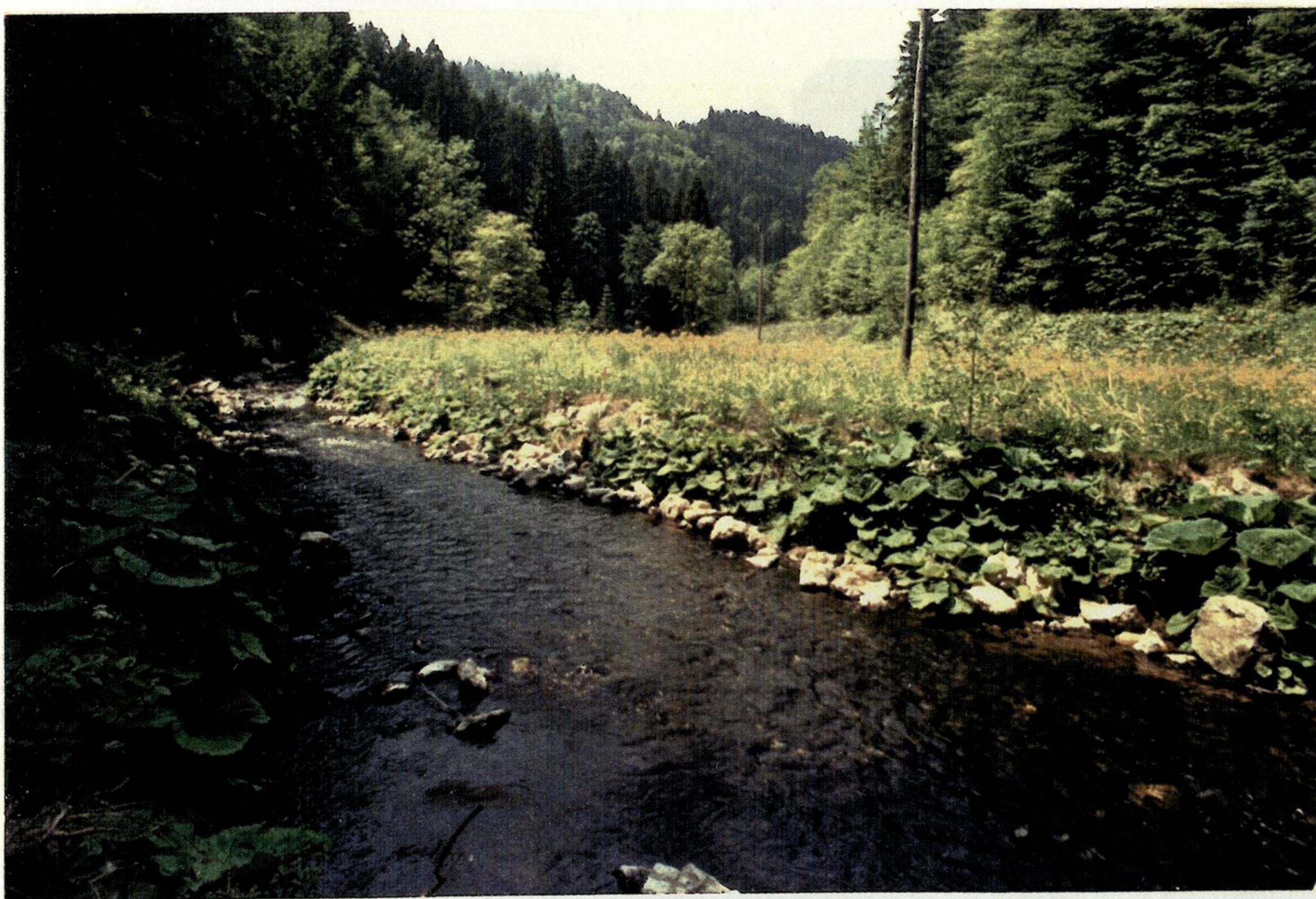
SLIKA št. 12 : MALA VODA - enostransko obrežno zavarovanje - naravno oblikovanje struge (foto: M.Zemljic, 1988)
