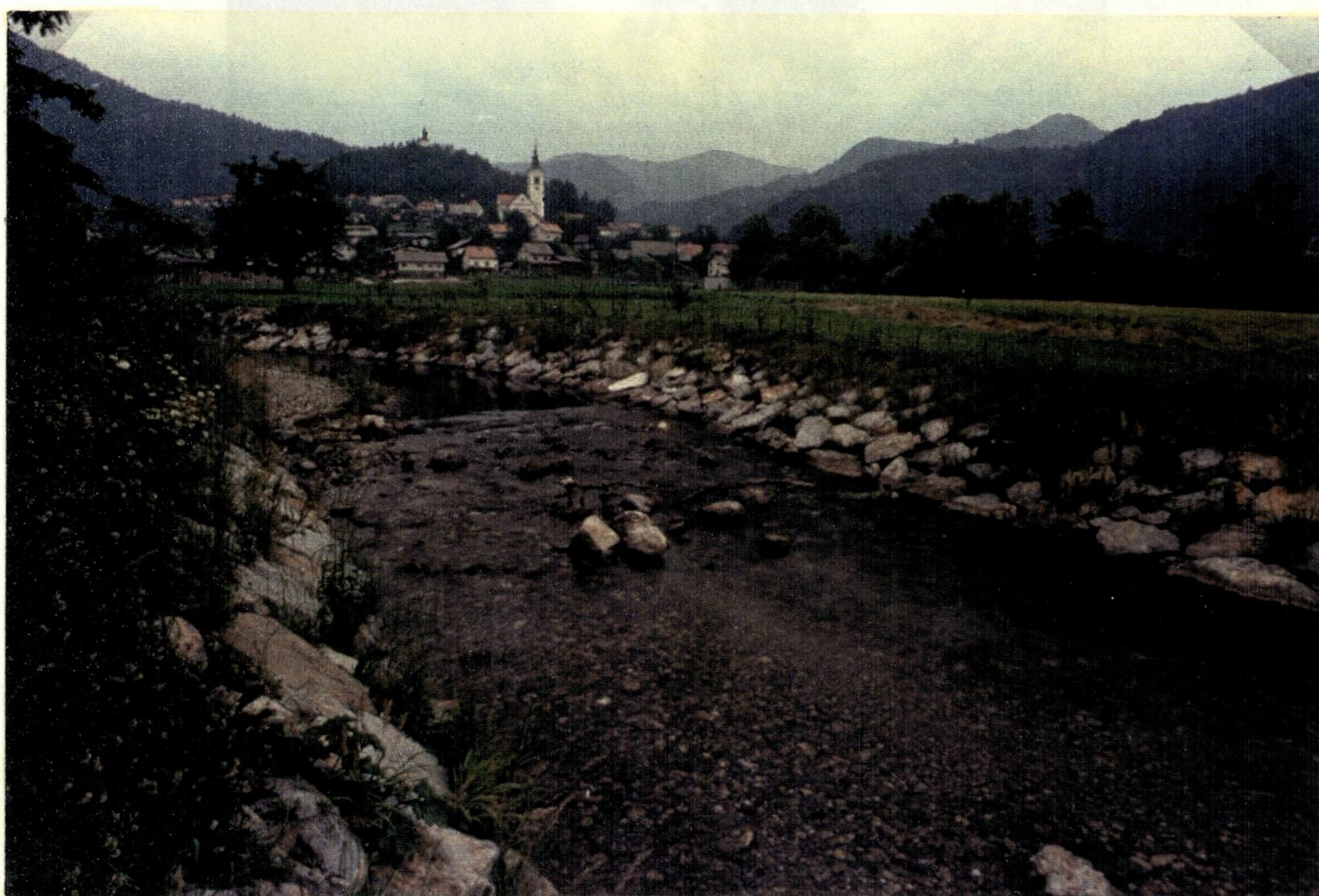
SLIKA št. 19 : MALA VODA pri Nartniku - deflektorji v strugi hudournika (foto: M.Zemljic, 1988)
