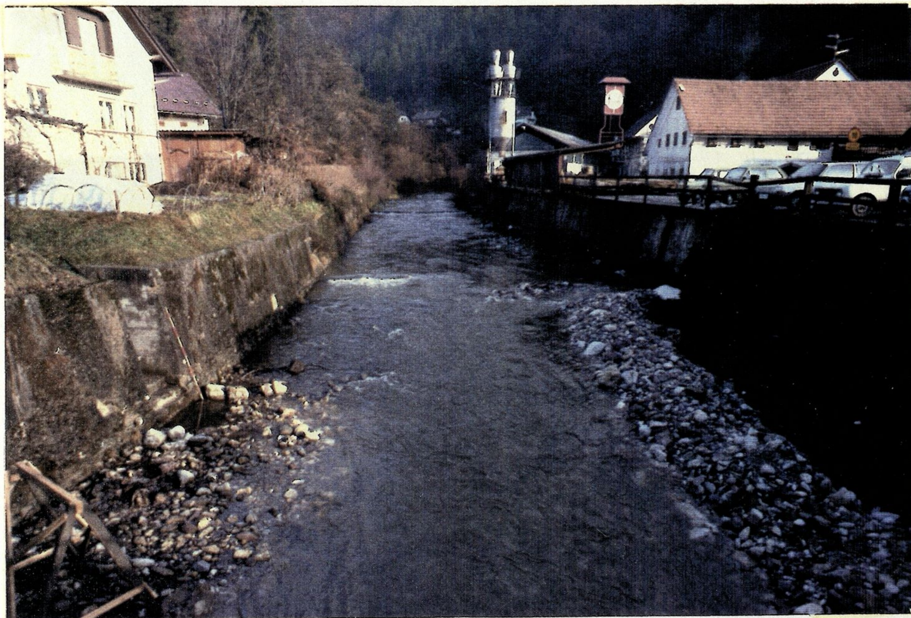
SLIKA št. 13 : BOŽNA v Polhovem Gradcu - okolju manj prikladna premočrtna ureditev pogojena s stavbami (foto: M.Zemljic, 1988)
