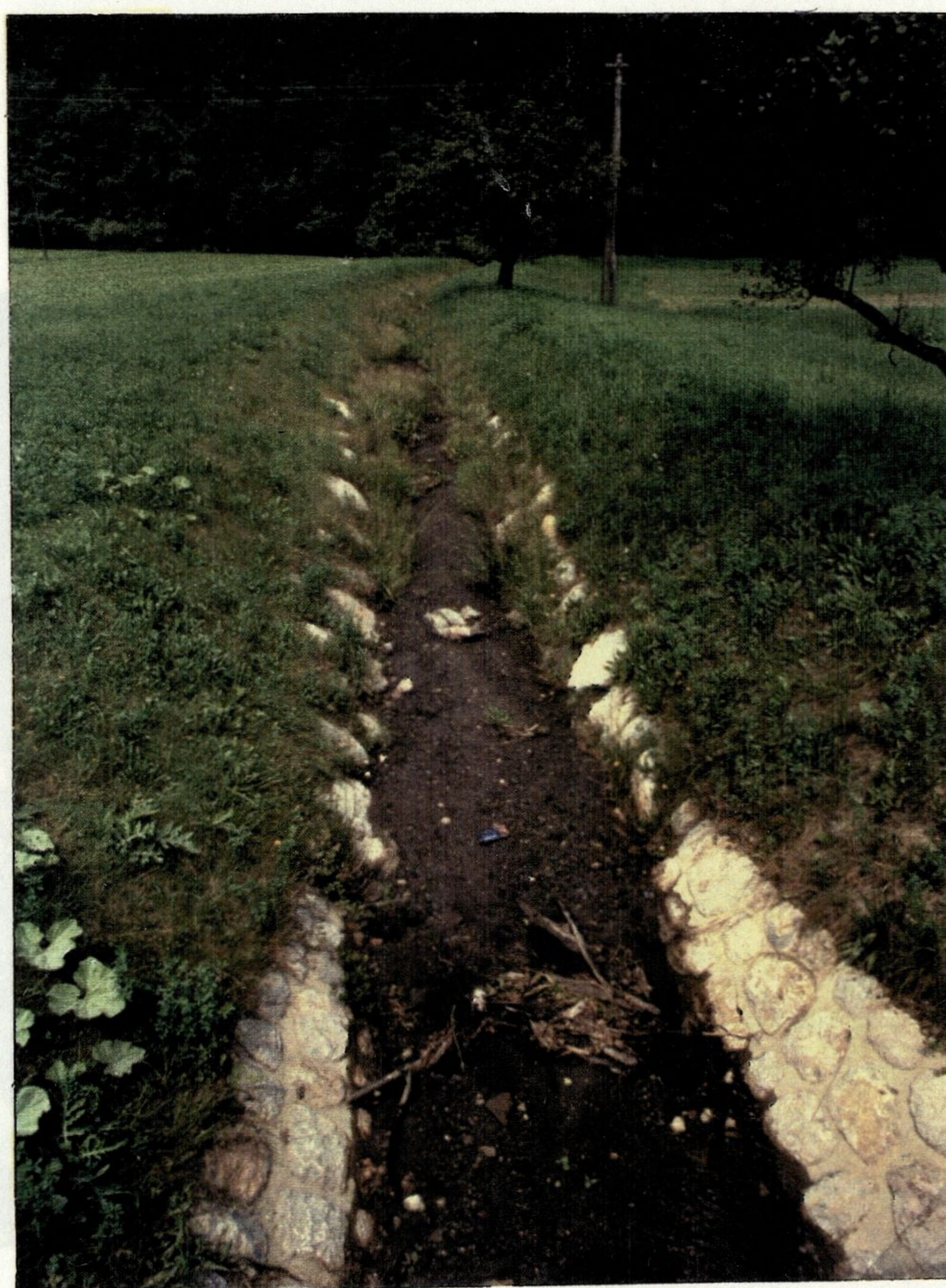
SLIKA št. 18 : ČRNI POTOK - oblikovanje kinete, skladnejše z okoljem (foto: M.Zemljic, 1988)
