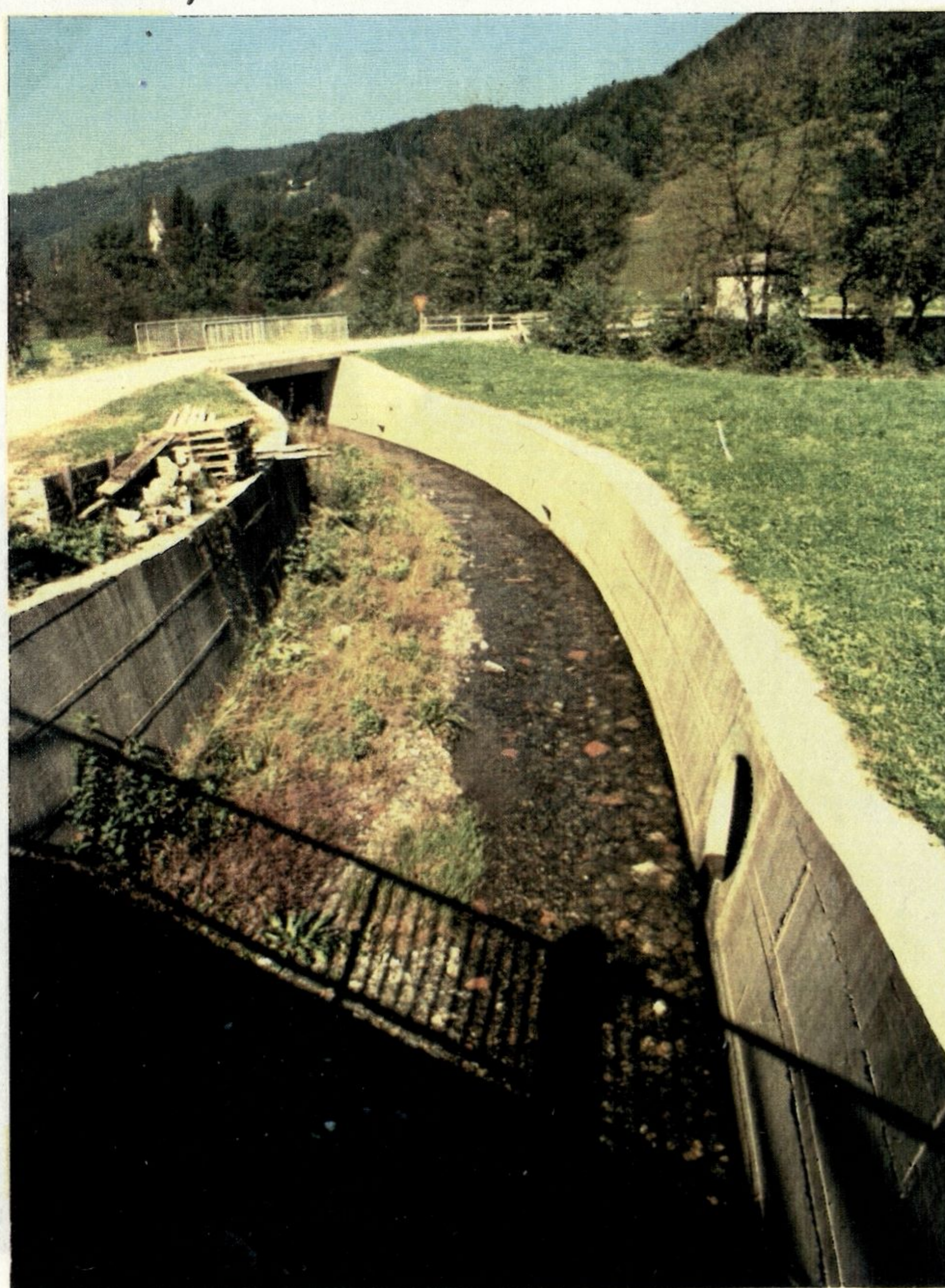
SLIKA št. 30 : PROŠČA - ribja skrivališča v obrežnem zidu v Dolenji vasi (foto: M.Zemljic, 1990)
