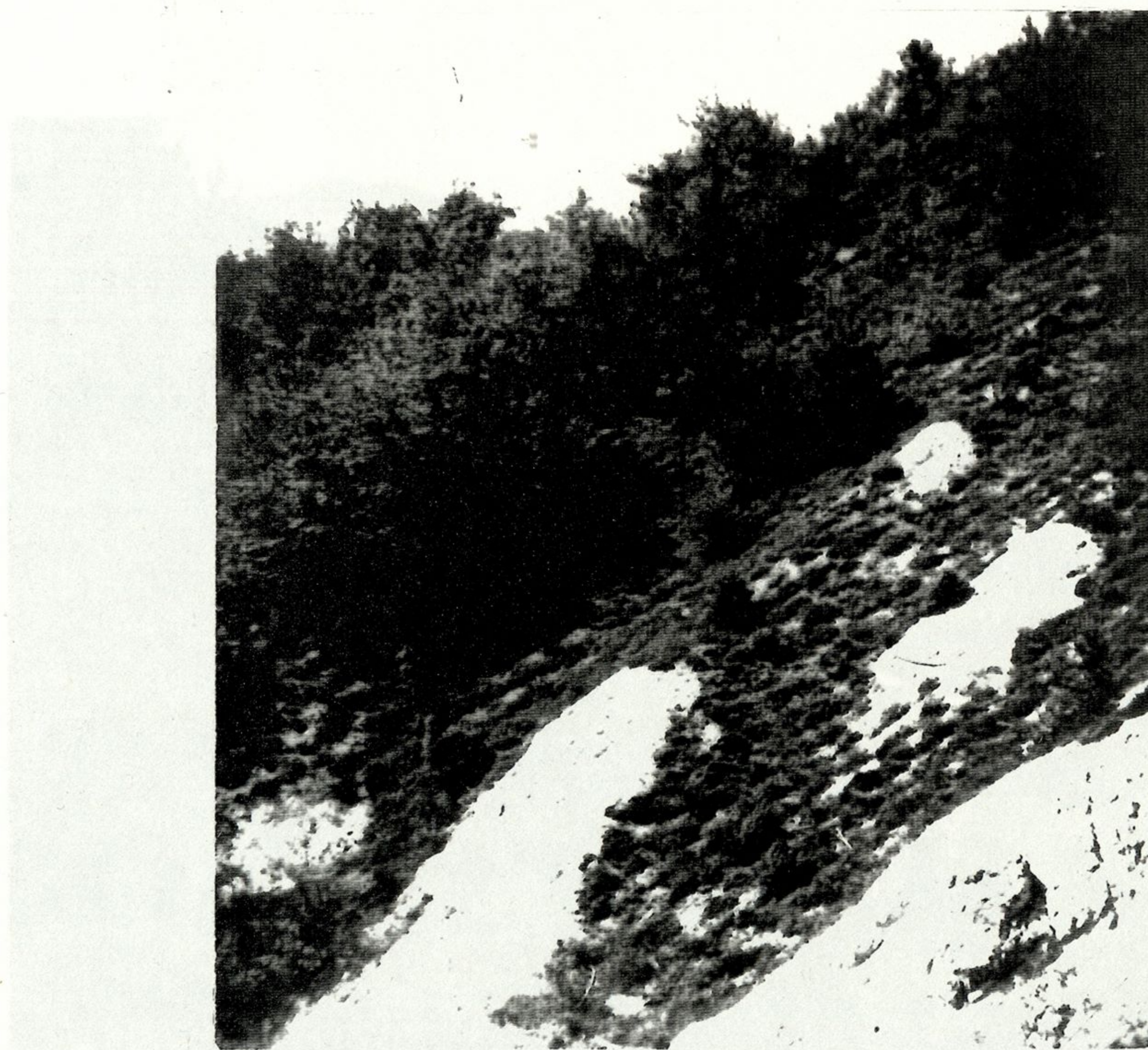
SLIKA št. 6 : PETRIČEV POTOK - zatravljavanje ogolelega in izpranega dolomitnega pobočja z rušami (foto: A.Štrancar)
