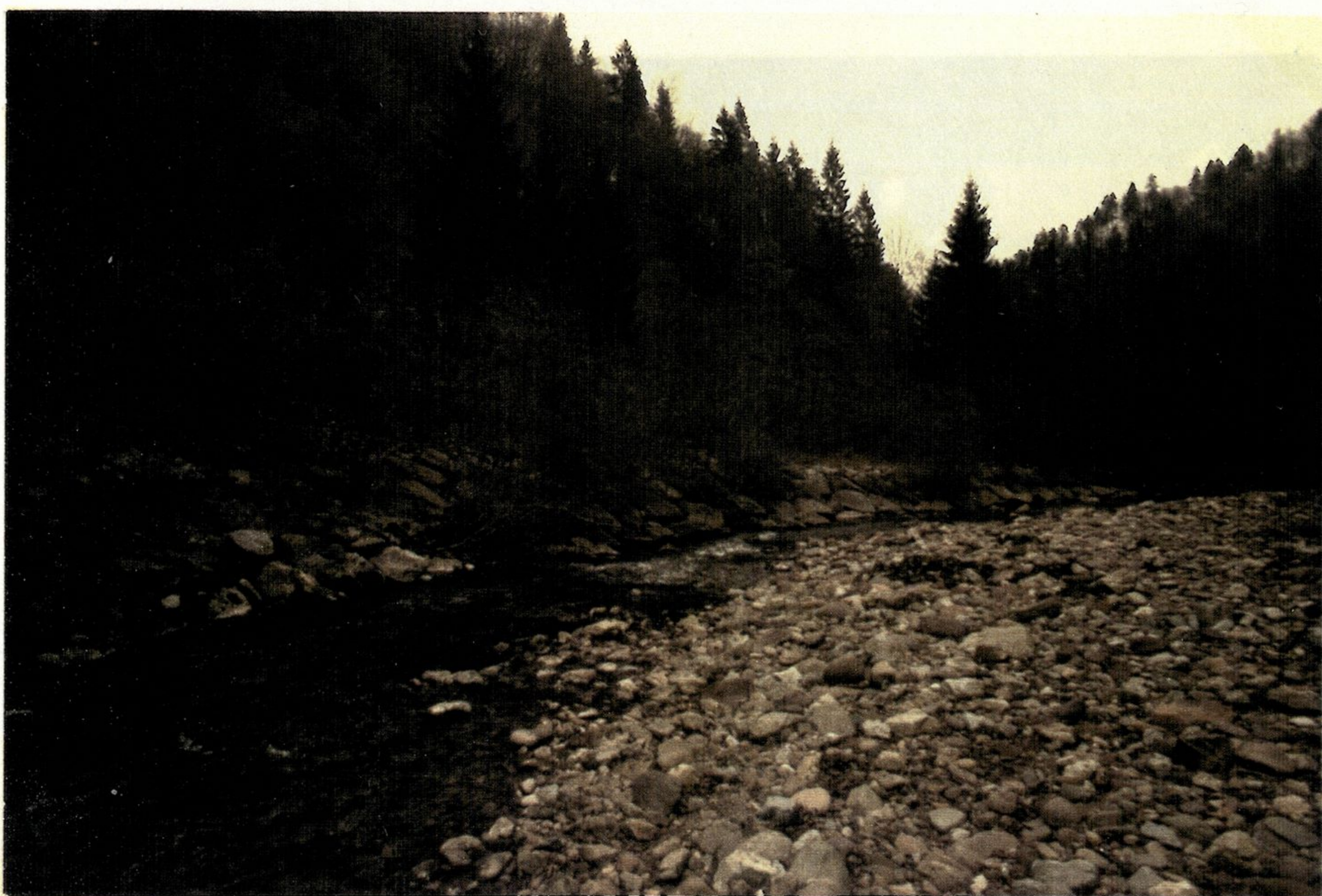
SLIKA št. 11 : BOŽNA - enostransko obrežno zavarovanje - naravno oblikovanje struge (foto: M.Zemljic, 1988)
