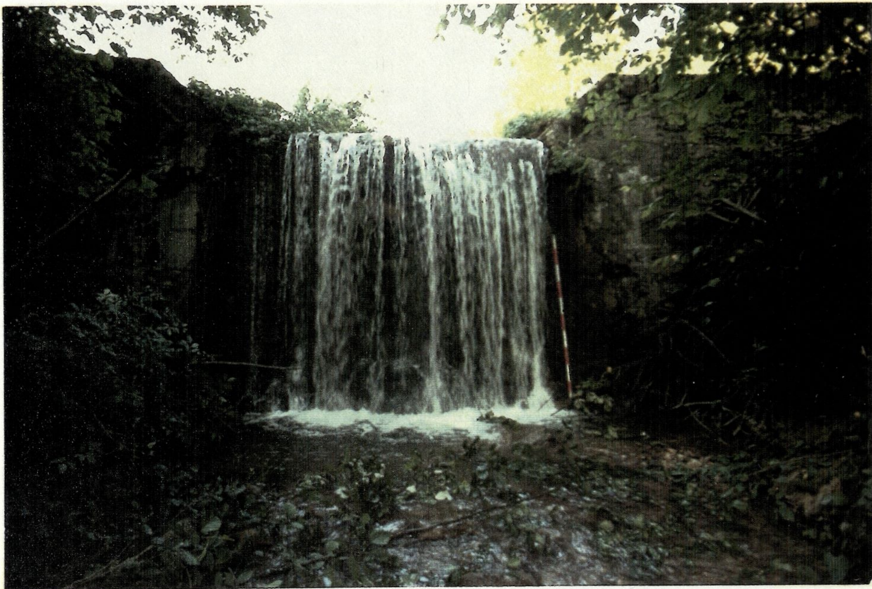
SLIKA št. 25 : MAČKOV POTOK - pregrada z neutrjenim podslapjem (foto: M.Zemljič, 1988)
