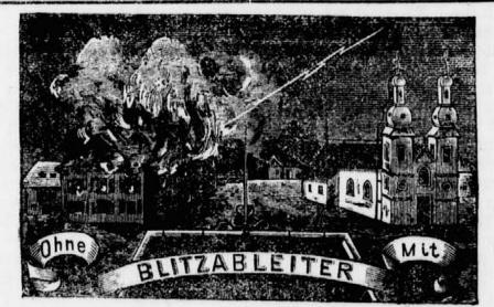
solidester Construction mit Platinspitze und feuervergoldeten Fängern, für Kirchthürme, Häuser wie alle der Gefahr des Blitzstrahles ausgesetzten Objecte, werden bei Gefertigtem billigst verfertigt und von ihm persönlich angelegt. Auch werden von demselben veraltete unverlässliche Leitungen gegen billigste Berechnung mittelst eines electrischen Probir-Apparates untersucht, etwaige Mangelhaftigkeit derselben schnellstens beseitigt, sowie abgestandene Spitzen gut und stark feuervergoldet.
