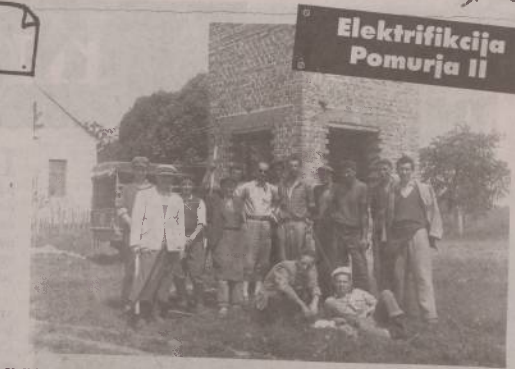
Vaški gradbeni odbor in »desovci« iz Murske Sobote pred transformatorjem. Groba gradbena dela na transformatorju so končana, inšpekcija iz Murske Sobote je z videnim zadovoljna, sklepna elektrifikacijska dela se lahko začnejo. Z desne proti levi: Geza Veren (2.), projektanti Potočnik iz Maribora (5.), Hradil Vlado (6.) in takratni obratovodja Vladimir Kukanja (7.) V ozadju ameriški vojaški džip Willys, edino prevozno sredstvo elektrifikatorjev, ki so ga potrebovali samo za najnujnejše. (Če se je kdo od domačinov prepoznal ali prepoznal kraj, kjer stoji transformator, naj nam to sporoči.)
