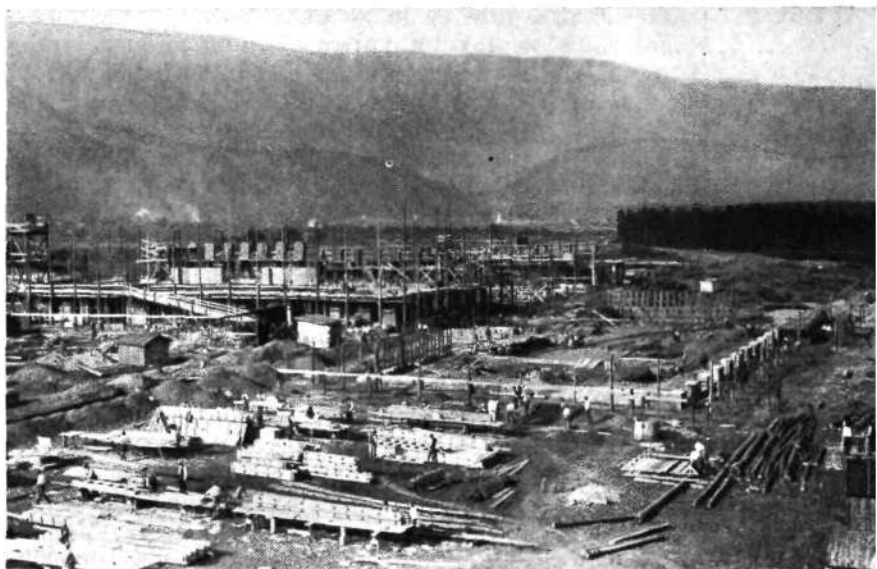
Graditev tvornice v avgustu 1. 1917.
