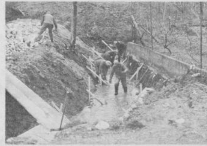
Hudourniški potok v Žetalah ne bo več poplavljal.
