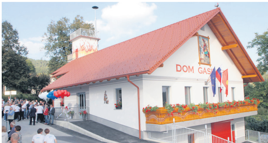
Nov gasilski dom PGD Velika Pirešica stoji na mestu starega. V primerjavi z njim je nekoliko večji, predvsem pa modernejši in bolj prilagojen potrebam gasilcev.
