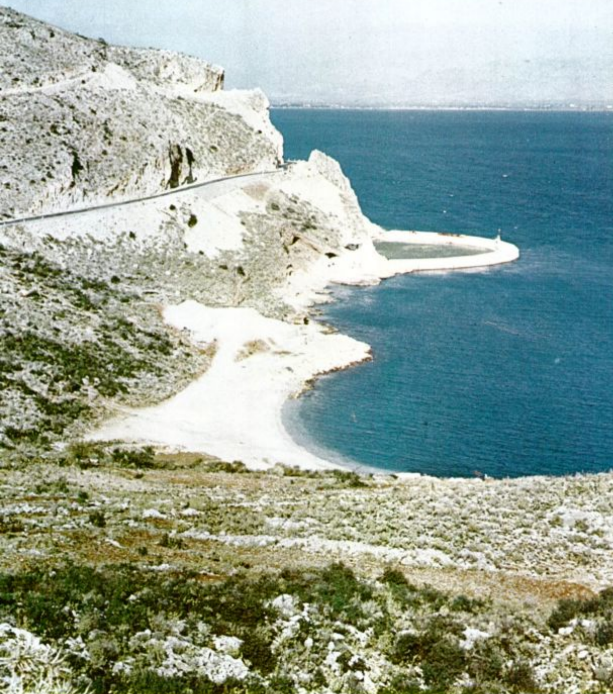
Sl. 21. Polkrožna pregrada pri Kiveriju v Grčiji Fig. 21. Semicircular dam at Kiveri in Greece
