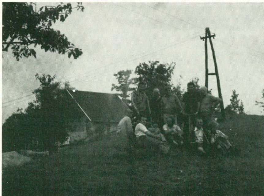
Udarniki za izgradnjo doma na Brnici
