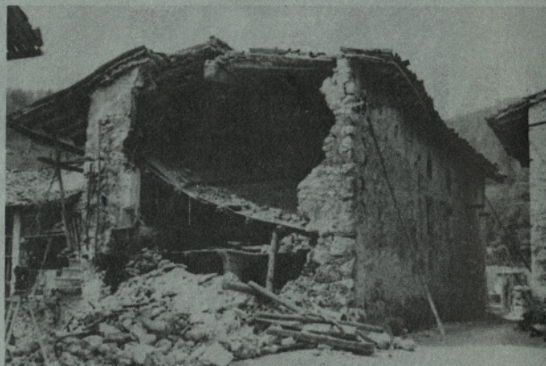
Slika 2: Porušitev zidu zaradi nihanja pravokotno na ravnino (Posočje, 1976. Foto J. Boštjančič)
