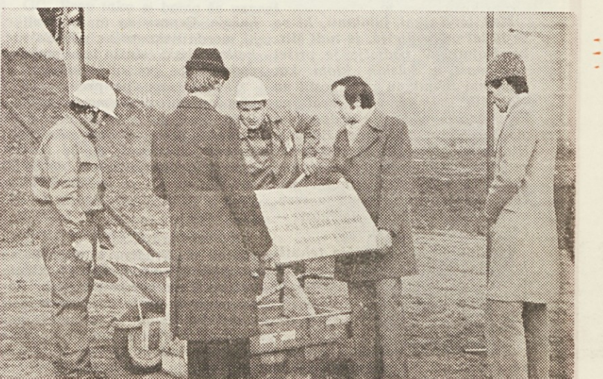
Polaganje temeljne plošče za izgradnjo tovarne sladkorja v Ormožu
