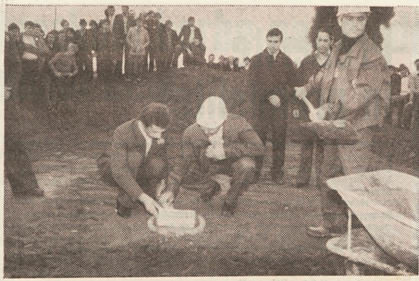
Polaganje temeljnega kamna za izgradnjo nove hale za Avto Radgono
