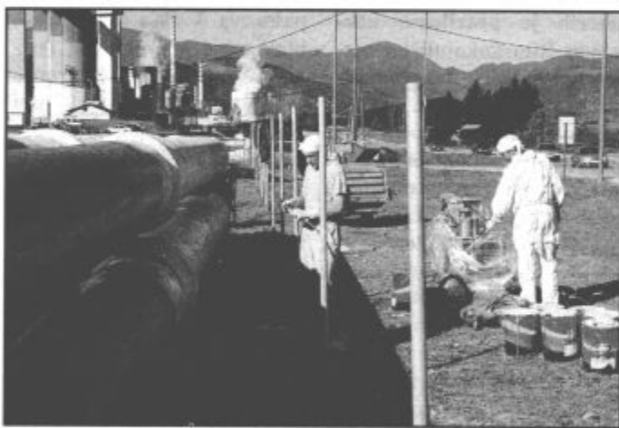
Obnova podporja in izolacije na magistralnem vodu od Teša do centralne energetske postaje naj bi pomembno prispevala k zmanjšanju toplotnih izgub in stroškov energetske oskrbe.
