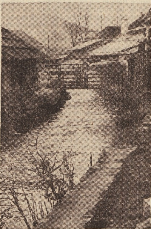
Das Tübelbett im alten Zustand
