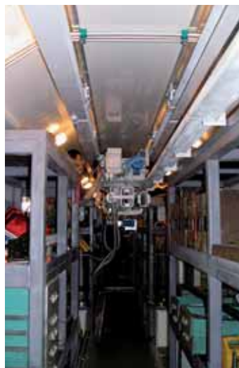
Na sredini stropa je dvigalo za vnos in iznos težke opreme na čelu sklepa vlaka in ob bočni strani.
