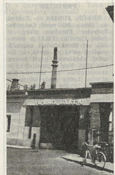
Popravilo tovarniškega dimnika je dokaj nevarno, vendar je treba delo opraviti
