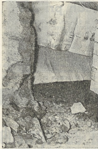
To je skladišče celuloze. Precej nosilnih stebrov je več ali manj že poškodovanih. Razkladalci, ali se zavedate odgovornosti in posledic?
