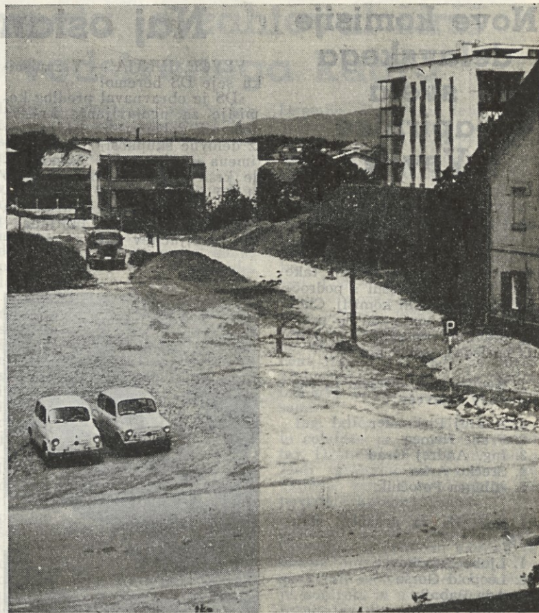
Gradnja nove ceste pred upravnim poslopljem na Vevčah
