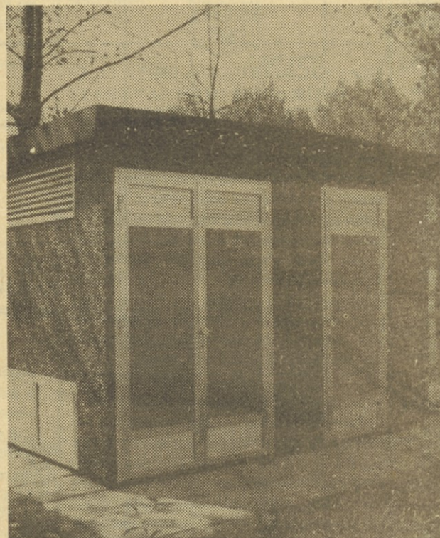
In takšna je trafo postaja, ko je gotova. Fasado gradbinci prilagodijo okolju. Dosedanji način gradnje je trajal približno 1 mesec, montaža te trafo postaje pa je gotova v 8 urah. Gradbinci jo naročniku sestavijo v 7 dneh od prejema naročila. Trafo postajo je možno razstaviti in jo ponovno sestaviti na drugem prostoru.
