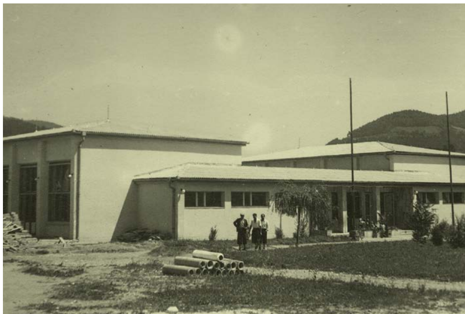
Dom železarjev tik pred dograditvijo (1952)
