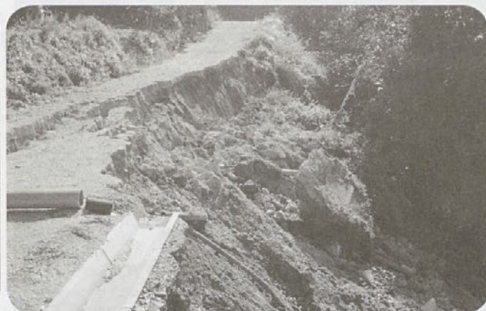
Eden največjih zemeljskih plazov - Jevnica.
