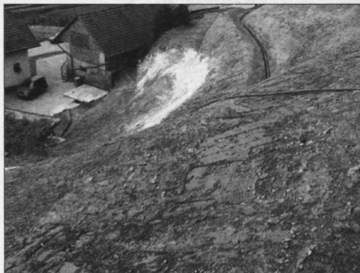
Končna sanacija plazu nad domačijo Turk z odvodnjavanjem
