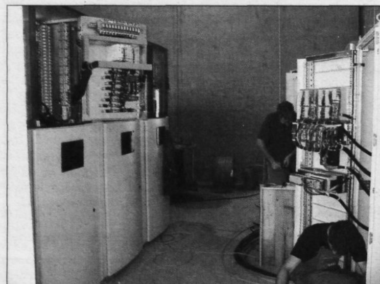
Montaža 100 kV GIS stikališča se je zaključila.
