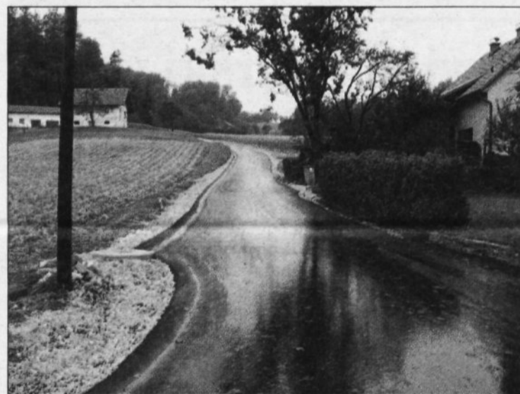
Na Porebru je urejeno odvodnjavanje, tampon in na novo položen asfalt
