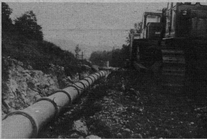
Gradnja kolektorja tik ob Savinji je zelo zahtevna
