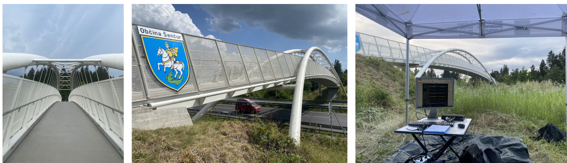
Slika 1: Vzdolžni in prečni pogled na kolesarski most z merilno postajo.
