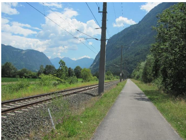
Slika 5: Umestitev kolesarske poti 5 m od osi železniške proge (Avstrija; foto Uroš Rozman)
