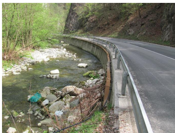
Slika 4: Prikaz problematičnega odseka državne ceste, ki je pod nivojem 100 letnih voda. (foto: Uroš Rozman)
