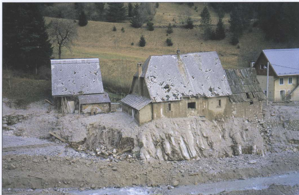
Slika 9: Od drobirskega toka poškodovane hiše v Gorenjem Logu (30. 11. 2000) (foto: Matija Zorn).
