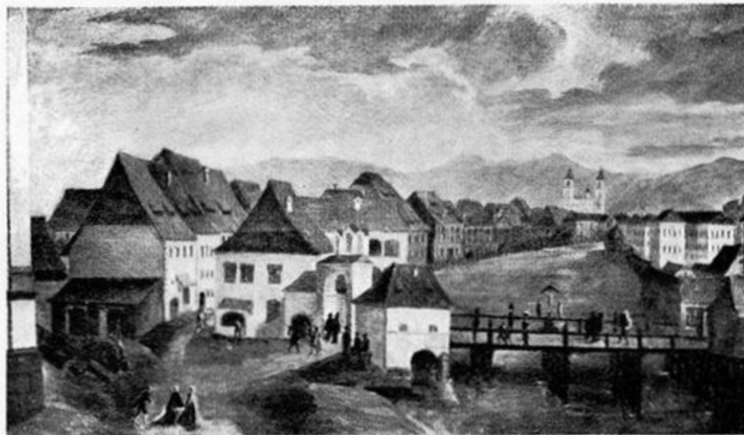
Špitalski most l. 1738. (Po Val. Metzingerjevi sliki v cerkvi sv. Petra v Ljubljani). Lepo se vidijo mostna vrata in znamenje na mostu. Kramarske kolibe še ne zakrivajo mostu
