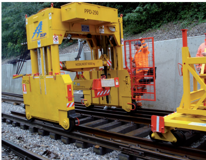
Stroj za polaganje betonskih panelov na projektu Košana–Gornje Ležeče
