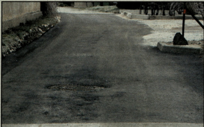
V Gotovljah so na makadamski dovoz do treh hiš vendarle položili grobi asfalt
