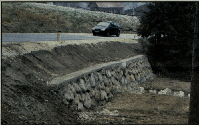
Na cesti Polzela-Andraž-Velenje so uspeli sanirati plaz
