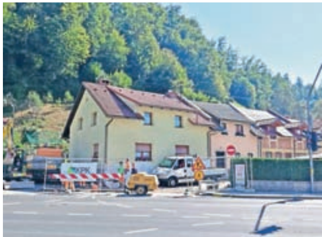
Na Novem trgu poteka obnova komunalne infrastrukture, zato bo cesta tudi za pešce do konca novembra zaprta.
