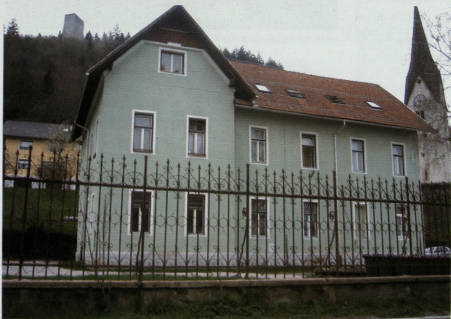
Zgradba bivšega zdravstvenega doma na Primorski cesti.
