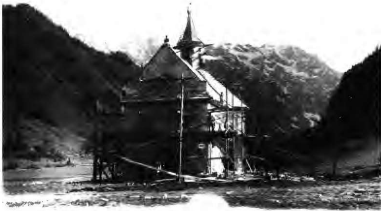
Cerkev v Logarski dolini med gradnjo
