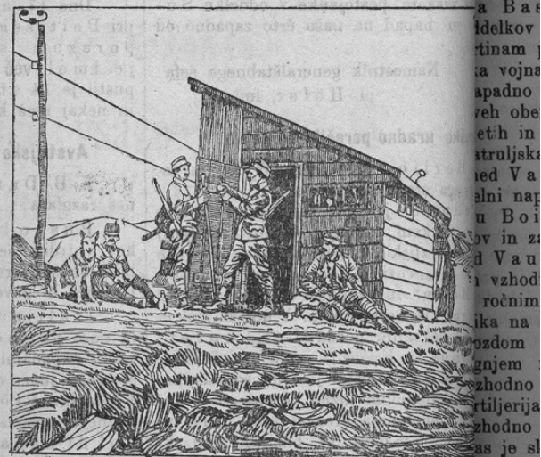
Eine Telefonzentrale in 3500m Höhe.
