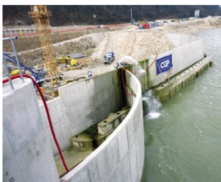
Slika 13 • Začasna gorvodna ločna pregrada in gorvodna zaščita druge gradbene jame
