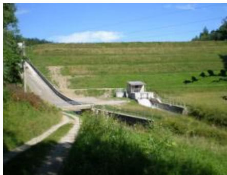
Slika 7 • Pregrada Klivnik z izpustom vode
