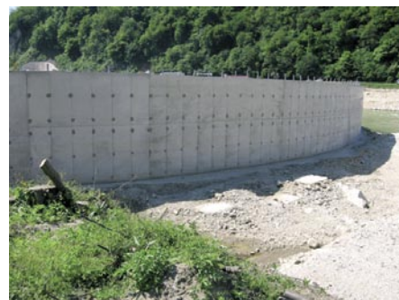
Slika 9 • Začasna gorvodna ločna pregrada; pogled z gorvodne strani
