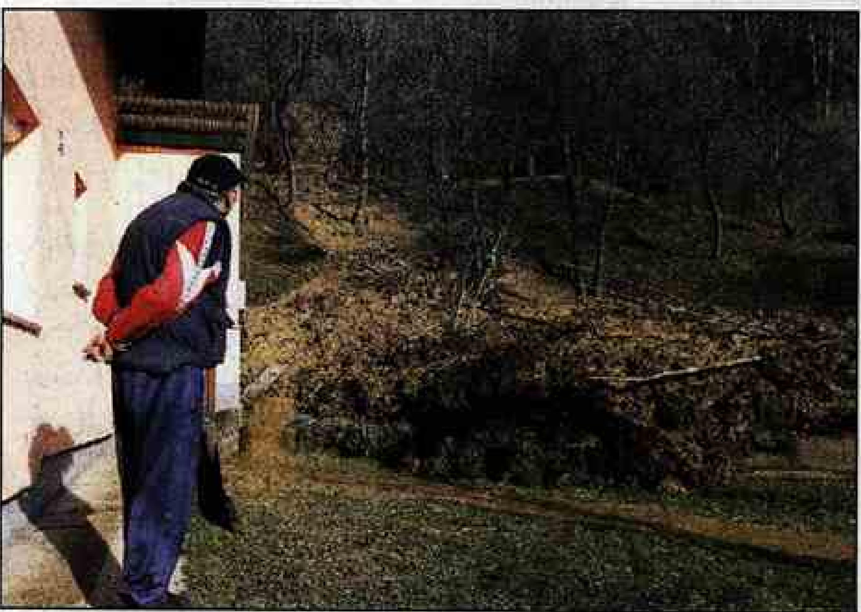
Zemeljski plaz na Mercu nad Jesenicami je ogrozil dve stanovanjski hiši. / Foto: Tina Dokl
