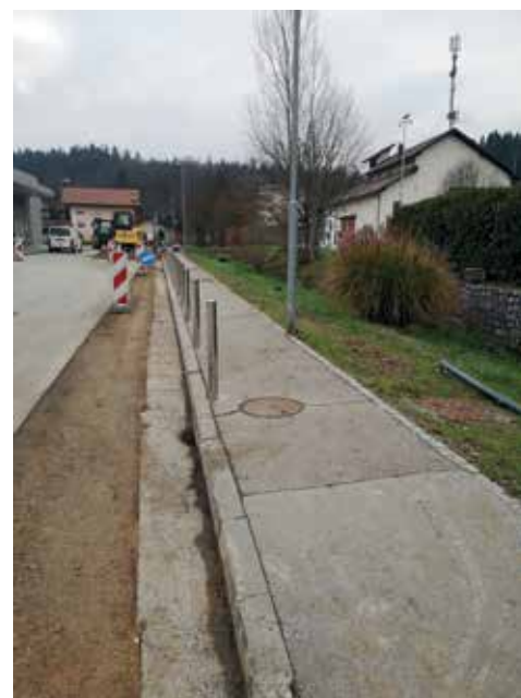
Na Gasilski ulici na Igu se je v novembru začela obnova javnega vodovodnega omrežja, saj na tem odseku vse pogosteje prihaja do okvar.
