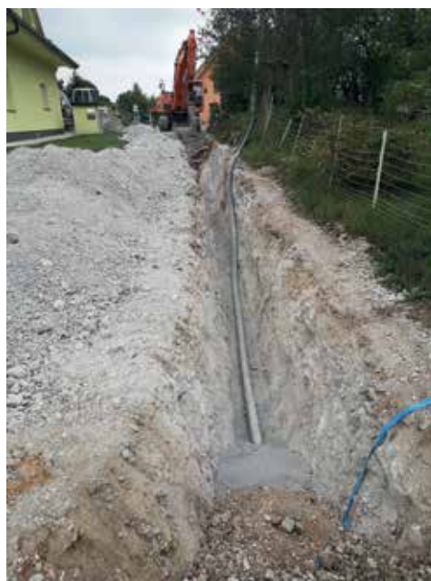
Na Golem v Hrastju je bil izveden vodovod, na katerega se bodo lahko priključili stanovanjski objekti.
