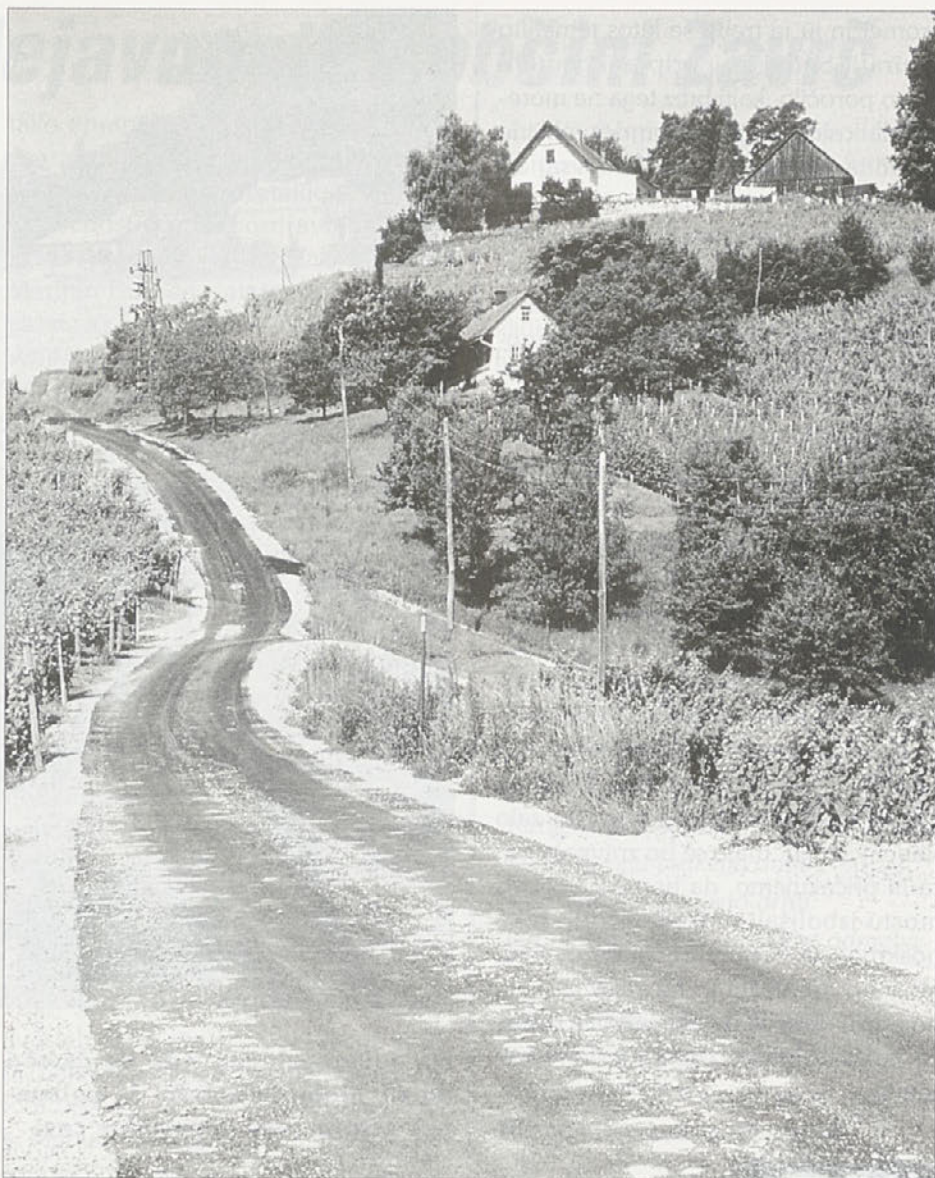
Cesta na Švabovo je asfaltirana sedaj tudi z druge strani, tako da bo dostop na ta vinorodni konec poslej mnogo lažji
