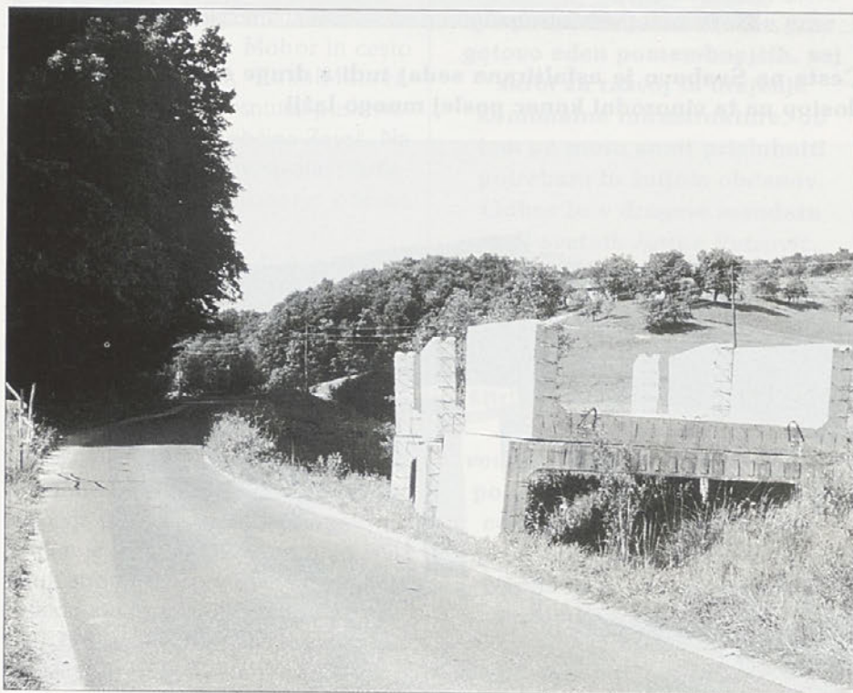
V Grebljicah bodo prenovili star, dotrajan most in ga zamenjali za novega, betonskega
