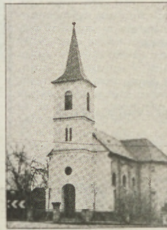
Župnijsko cerkev sv. Petra in sv. Pavla na Hotizi so zgradili 1924. leta s povečavo nekdanje kapelice.
