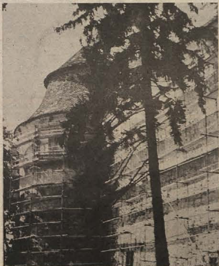
Obnova brežiškega gradu se nadaljuje. Letos sta na vrsti južna in zahodna fasada s stolpoma. Delo bo končano do jeseni. (Foto: Jožica Teppey)
