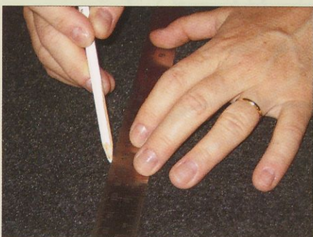
Slika 2. Merjenje in označevanje polsti za podlago
